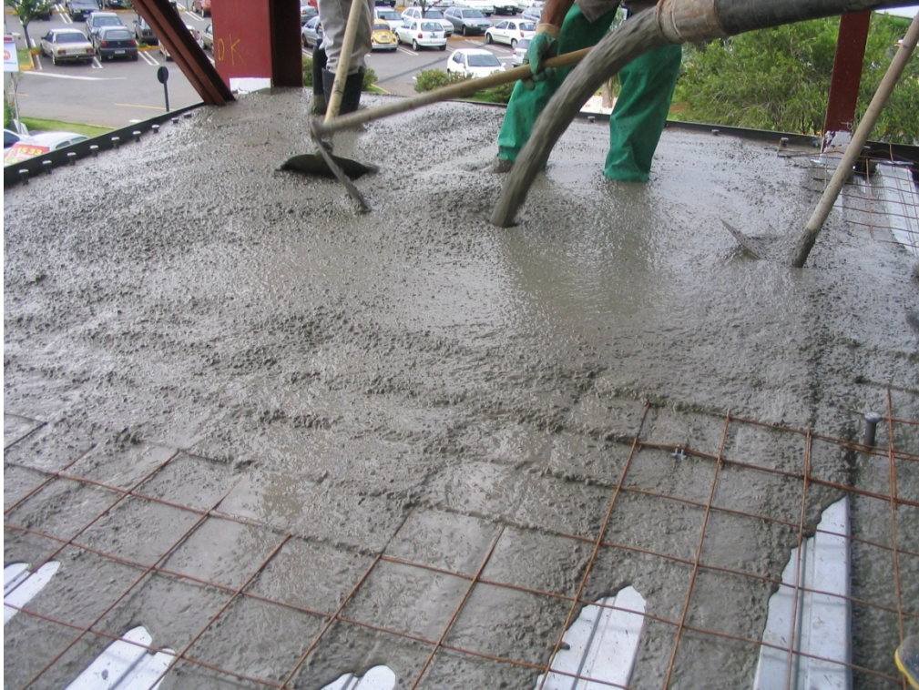
Figura 2. 1 - Lançamento de CAA em steel deck de um shopping Center
