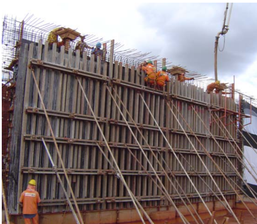
Figura 2. 5 - Aeroporto Internacional de Goiânia Santa Genoveva – concretagem da parede do subsolo com CAA – construtoras Odebrecht e Via Engenharia
