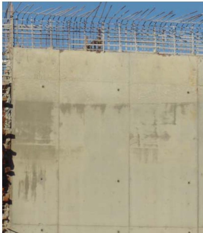
Figura 2. 6 - Parede do sub-solo após desforma
