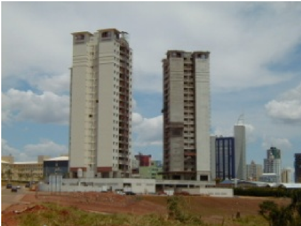
Figura 2. 4 - Edifícios residenciais construídos utilizando o CAA executados pela construtora Toctao Engenharia Ltda.
