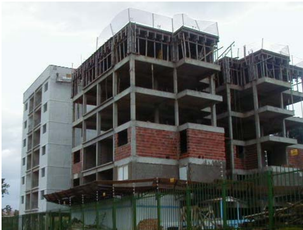
Figura 1. 3 - Obra realizada em Goiás com CAA pela construtora Arcel Engenharia Ltda. (GEYER et al. , 2005)
