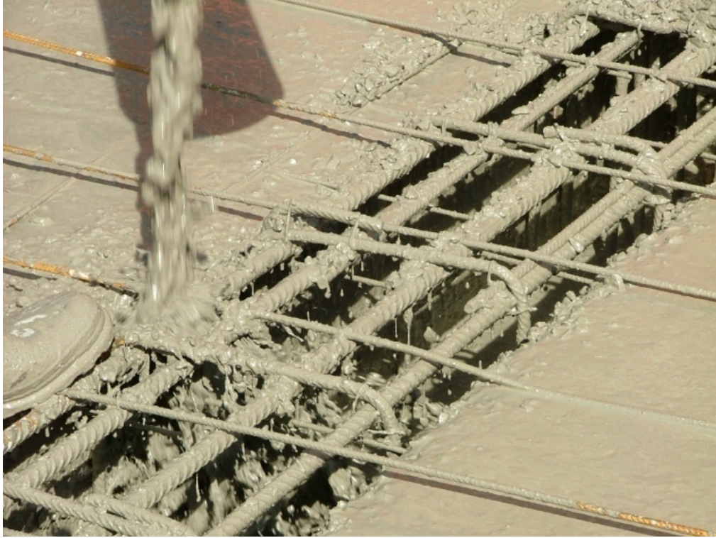
Figura 2. 3 – Concretagem do pavimento tipo de um edifício
