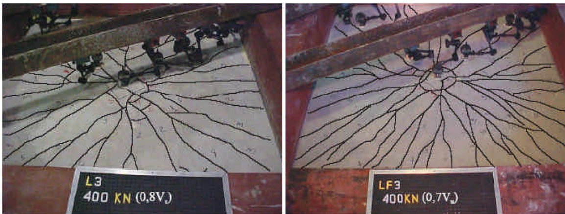
Figura 2.19 - Lajes L3 e LF3 próximas da ruptura – vista superior (MUSSE, 2004)
