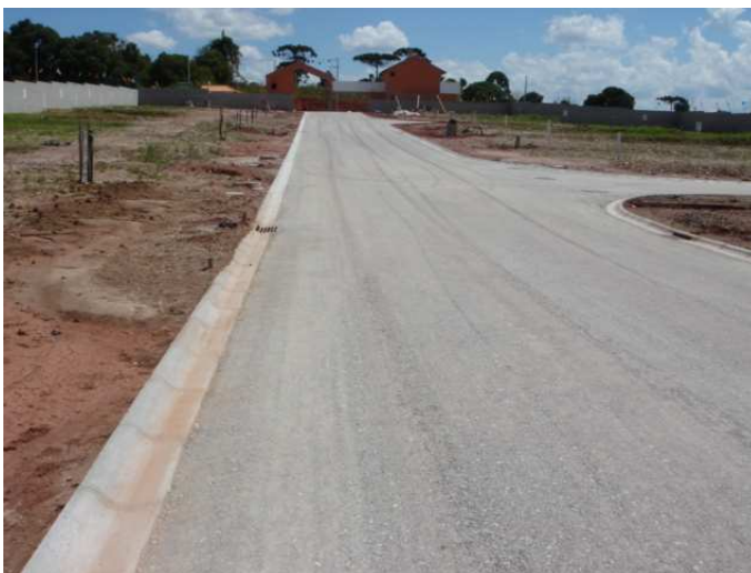
FIGURA 16 – Condomínio 2 – infra-estrutura pronta.
