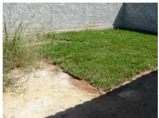
FIGURA 39 – Remoção de solo superficial.
