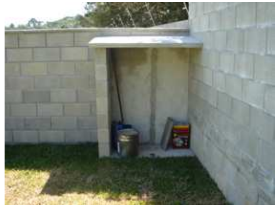
FIGURA 37 – Disposição incorreta de produtos químicos.
