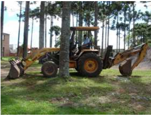
FIGURA 28 – Uso de máquinas na obra.
