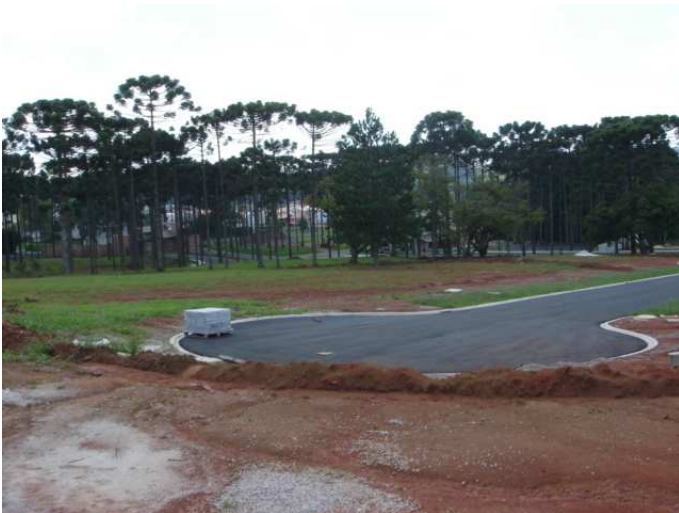
FIGURA 13 – Condomínio 1 – infra-estrutura pronta para construção de casas.
