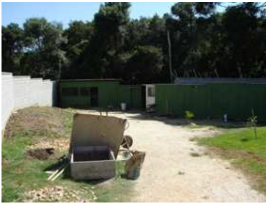
FIGURA 41 – Canteiro de obras.
