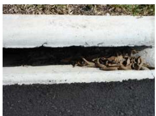
FIGURA 55 – Boca de lobo normatizada, sem grelha.
