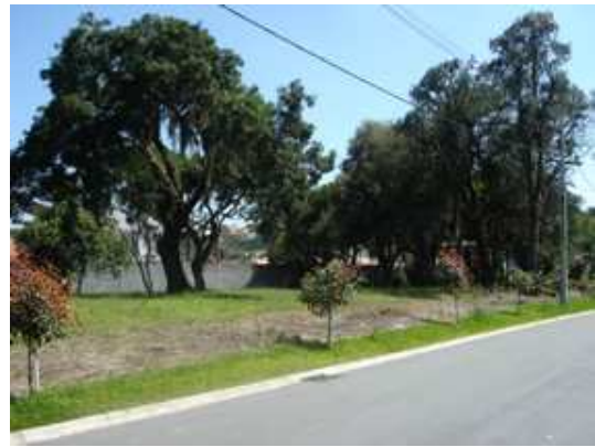
FIGURA 29 – Remoção de solo superficial e substituição por nova camada.
