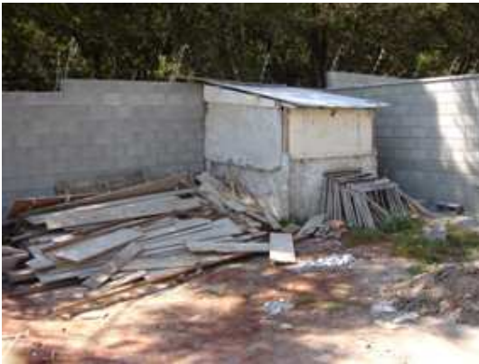
FIGURA 58 – Organização no armazenamento.
