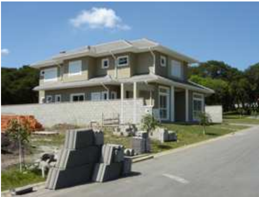
FIGURA 26 – Muros divisores entre terrenos.
