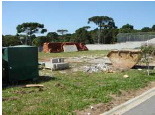
FIGURA 57 – Desorganização no armazenamento.
