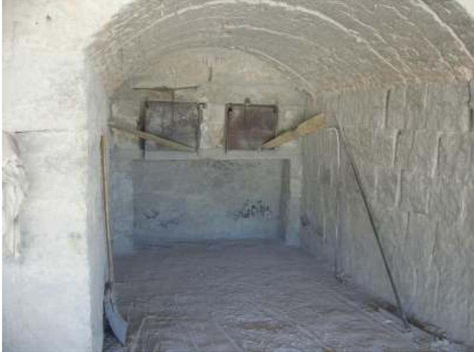
Figura 7 – Comportas da base do forno de cal operadas manualmente
