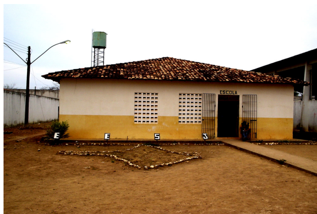
Figura 5 - Escola Estadual São José. Vista de frente:
