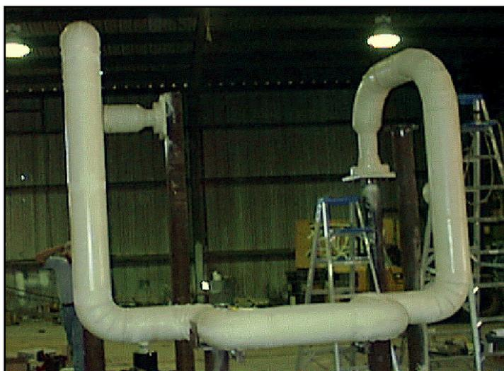
Figura 16: Aplicação do material térmico-isolante uretano sintético.
