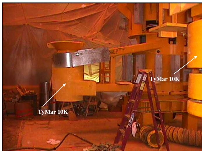
Figura 15: Aplicação do material térmico-isolante TyMar 10K.
