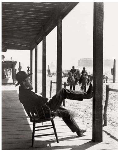
Figura 43 – ( Paixão de Fortes )
