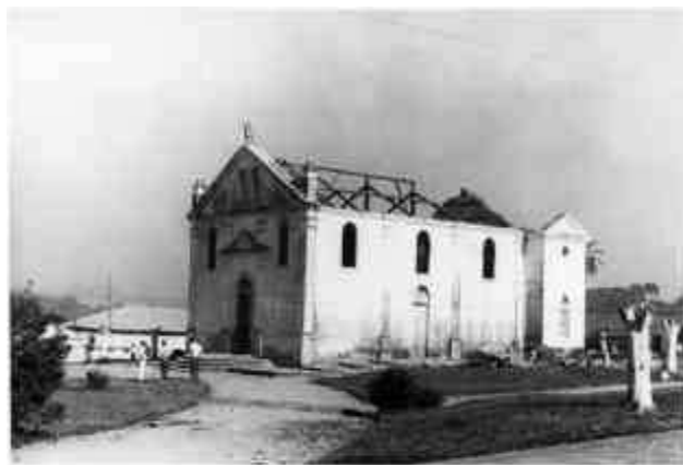
(Início da demolição da igreja de São Jose)
