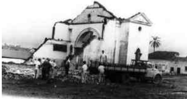
Foto da demolição da Igreja de São José. Fonte: http://sites.netsite.com.br/donizetti/bi72.htm , em 01/05/2006.
