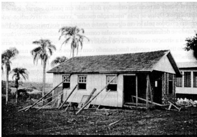
Figura 54 - Escola Comunitária da comunidade de Santa Fé: depois de quatro décadas de funcionamento foi leiloadada e adaptada para moradia. Fonte: EIDT, 1999.
