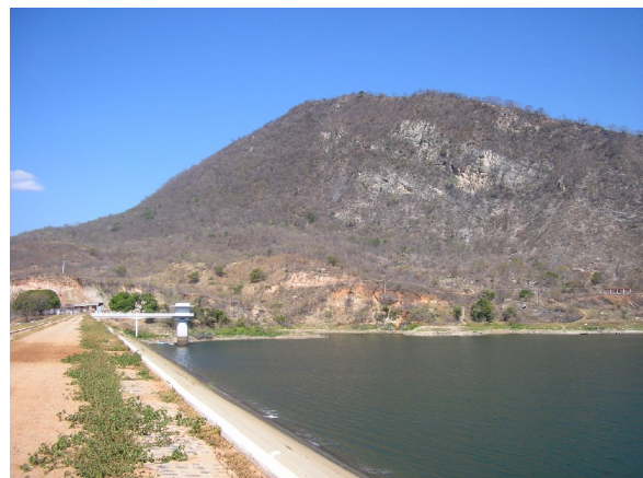
Figura 21: Ponto de captação de água da CAGEPA e a vista da serra ao lado da parede do reservatório durante a estação seca de 2007.
