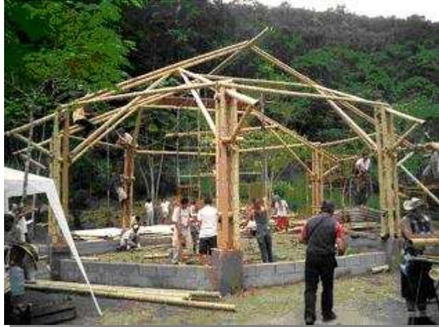
**Figura 17** - Construção em bambu
