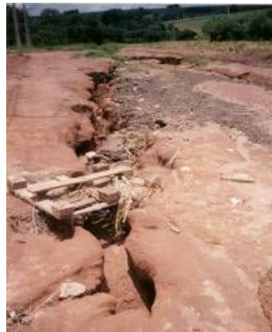
Fotos 28 e 29: À esquerda, buracos no asfaltamento do bairro Cruzado II. À direita, erosão causada pela chuva em área não asfaltada no bairro Cruzado II. (B. M. M., 2006; Cedida por Manoel, 2006)
