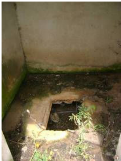
Fotos 32 e 33. À esquerda, local de onde deveria ser bombeado o esgoto dos bairros da porção Sudoeste da cidade para a estação de tratamento do Centro. À direita, ponto de encontro da água que desce da estação desativada (na vertical) com a água do córrego (na horizontal). (B. M. M., 2006)
