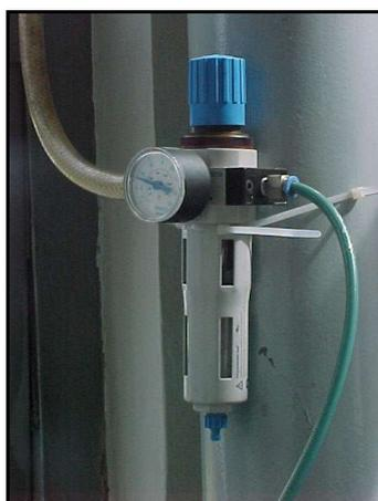
Figura 17 – Unidade de controle de pressão e filtragem do ar.
