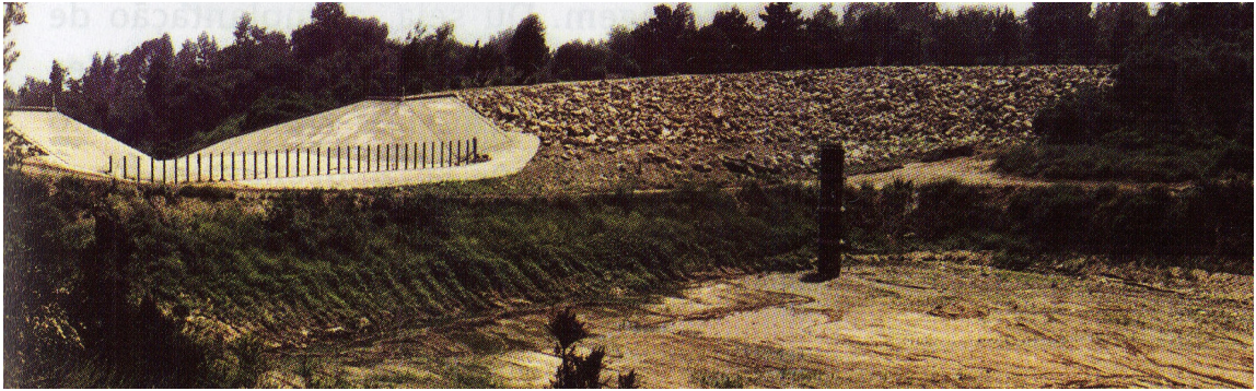
Figura 30 – Bacia de detenção e controle de ( debris ) detritos (Califórnia). Canholi, 2005.
