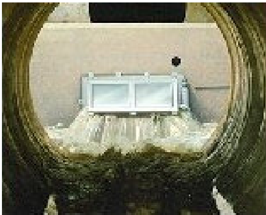
Figura 36 – Comporta para lavagem dos reservatórios. Paoletti, 2005.
