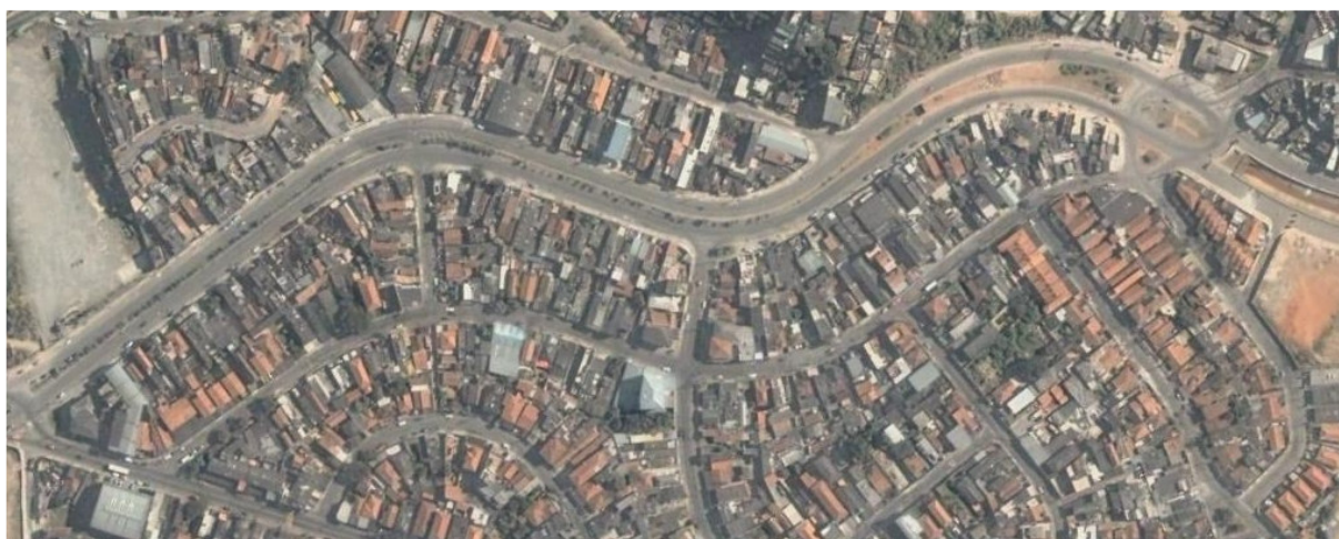
Figura 56 – Córrego Guaraú: canalização em galeria fechada e canteiro central. Google Earth. 2006.
