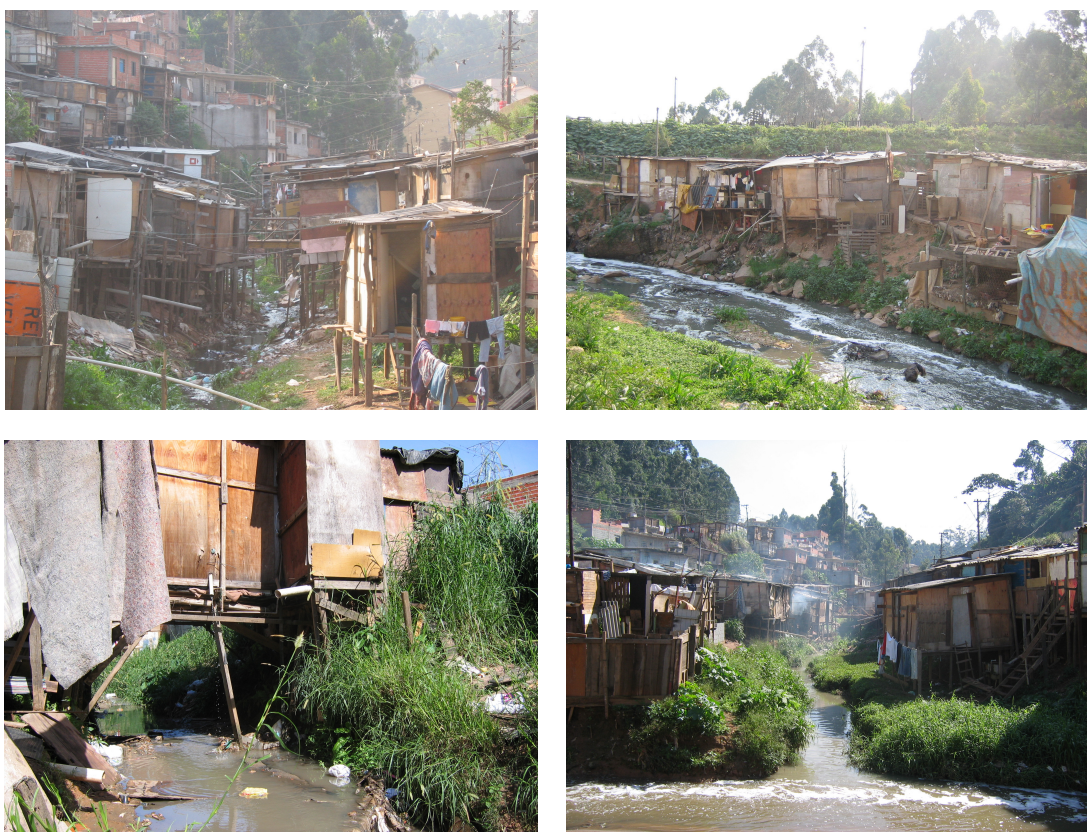
Figura 52 – Ocupação de margens e lançamento de esgoto in natura (Bacia do Bananal). Arquivo POLI, 2005.
