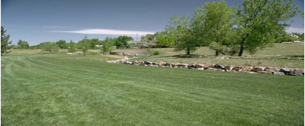
Figura 24b - (Bible Park) Bacia de detenção com múltiplas funções inteiramente integradas ao espaço. Urban Drainage and Flood Control District, 2001.
