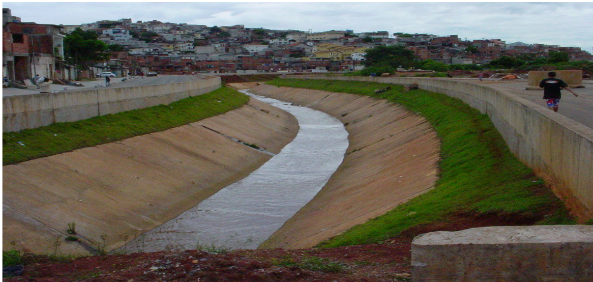
Figura 55 – Córrego Guaraú: canalização a céu aberto. EPUSP, 2005.
