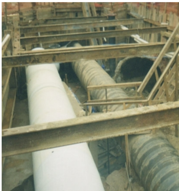
Figura 57a – Obras executadas para desvio do Córrego Guaraú.
