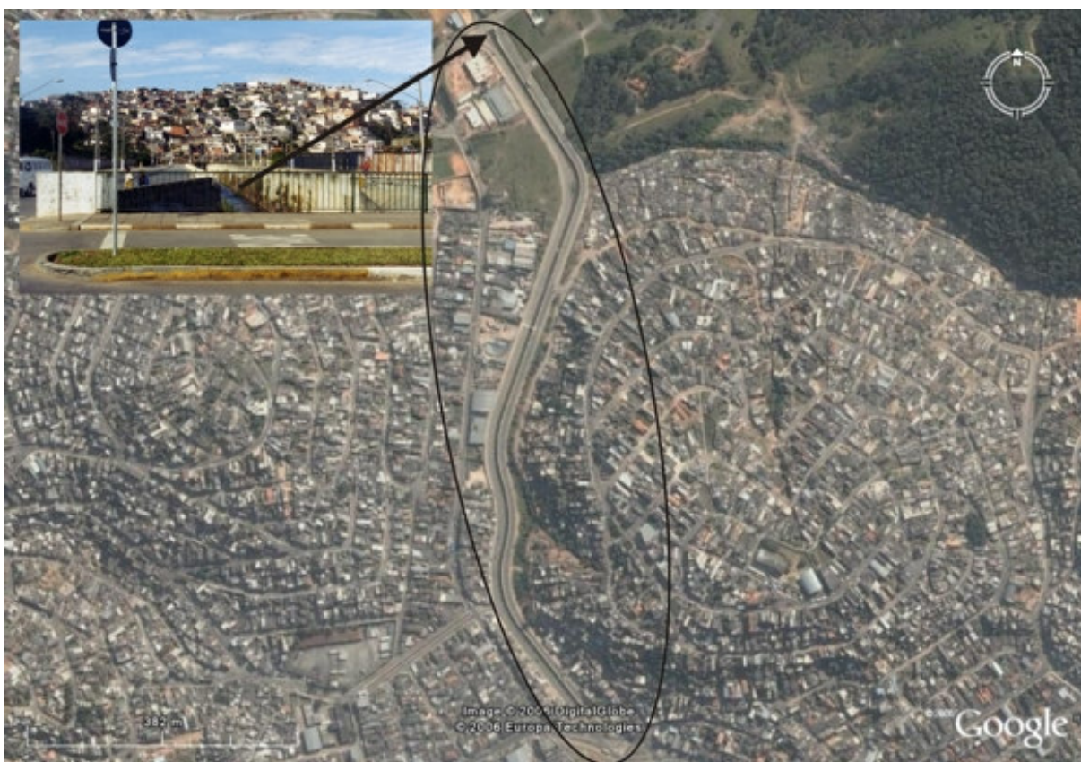
Figura 54 – Canalização a montante do Córrego Cabuçu de Baixo. Google Earth. 2006.
