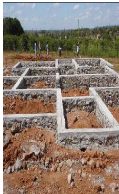
Imagem 18: Fundação das casas.
