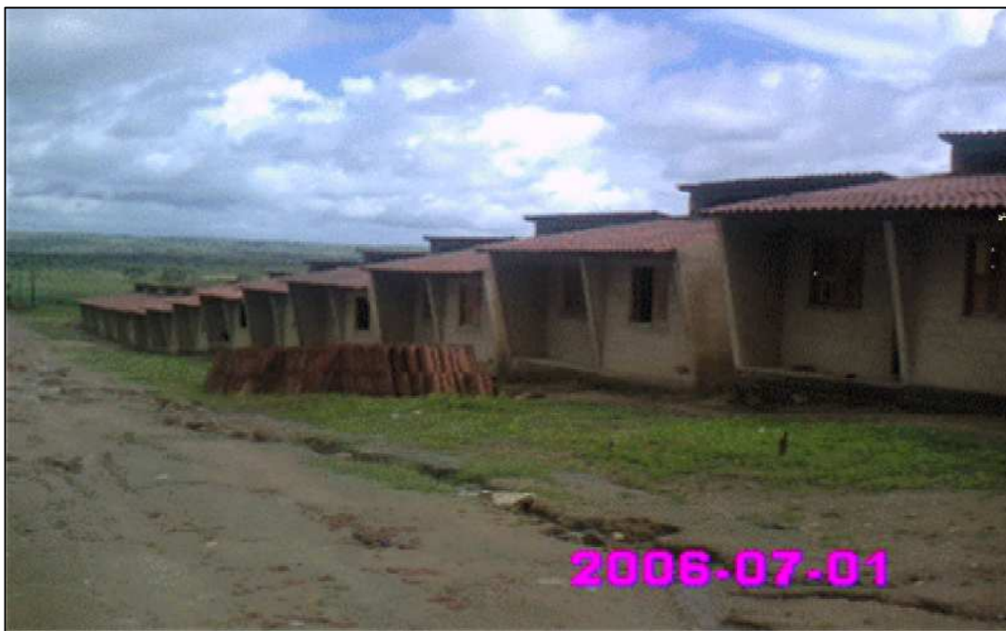
Imagem 14: Vista do conjunto habitacional entregue, sem pavimentação.
