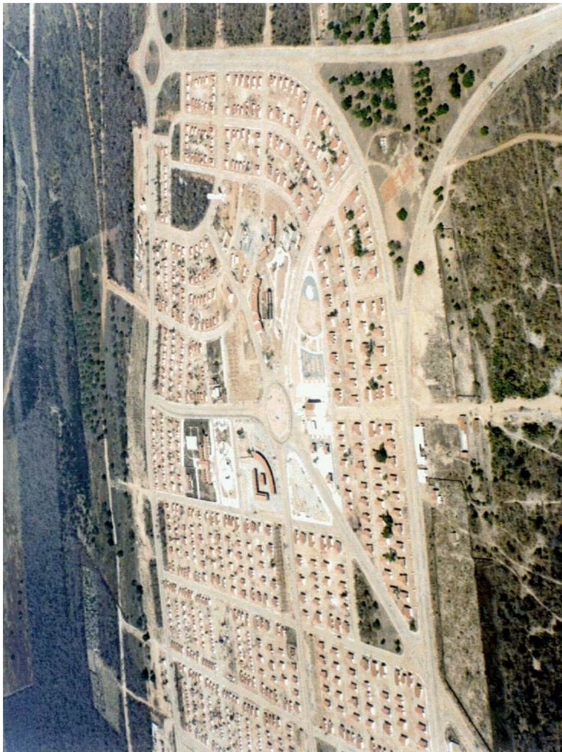
Figura 50: Foto aérea da cidade de Nova Jaguaribara ainda em fase de construção. Fonte: SEINFRA 2001
