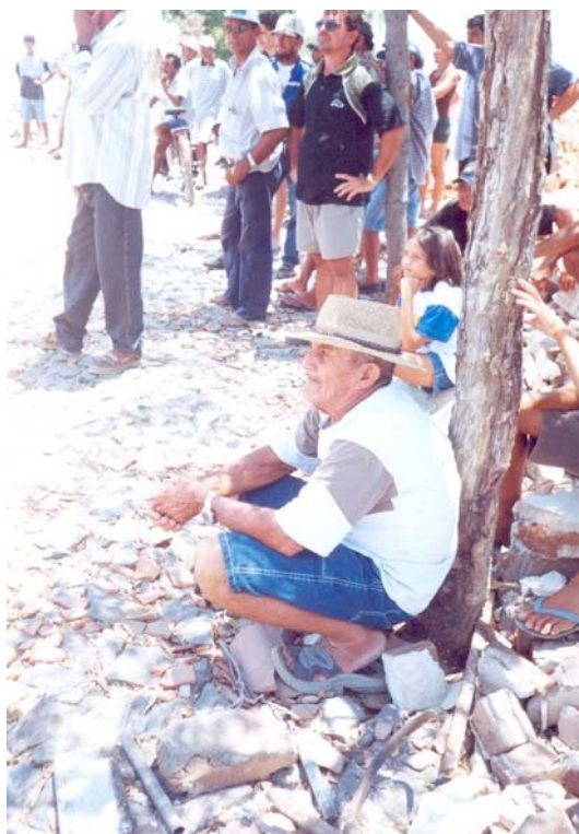
Figura 77: Moradores de jaguaribara assistem a demolição da Igreja Matriz
