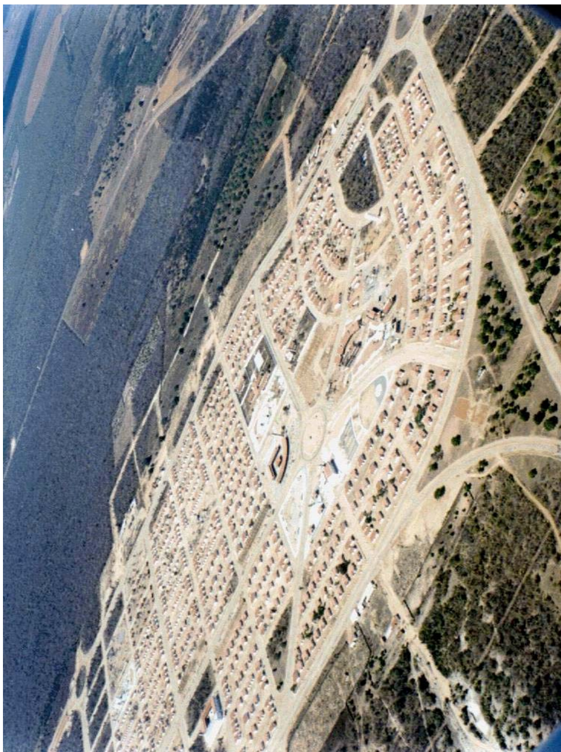
Figura 51: Foto aérea da cidade de Nova Jaguaribara ainda em fase de construção. Fonte: SEINFRA 2001
