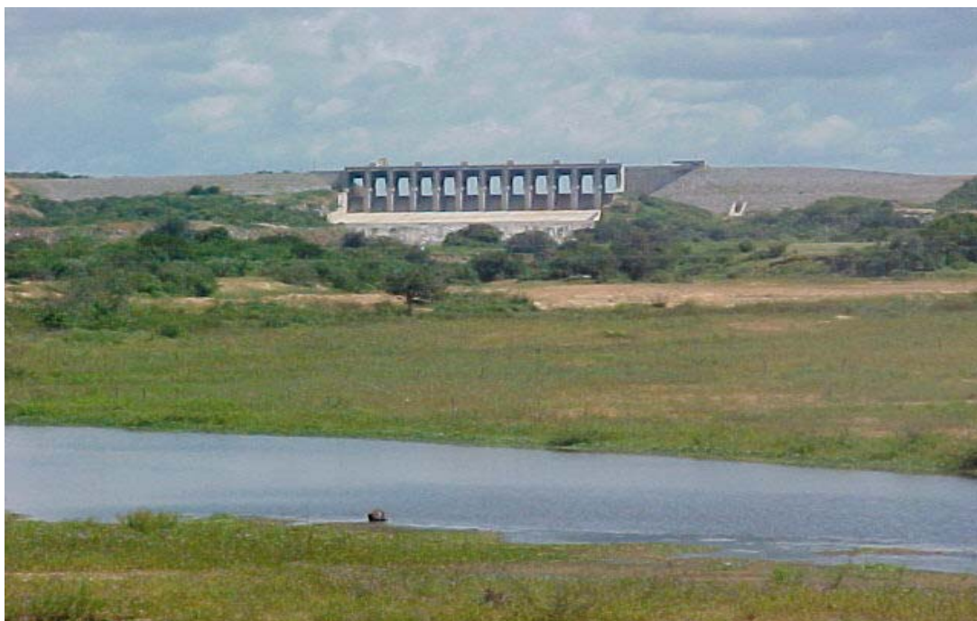
Figura 19: Barragem do Castanhão Fonte: DNOCS, 2004
