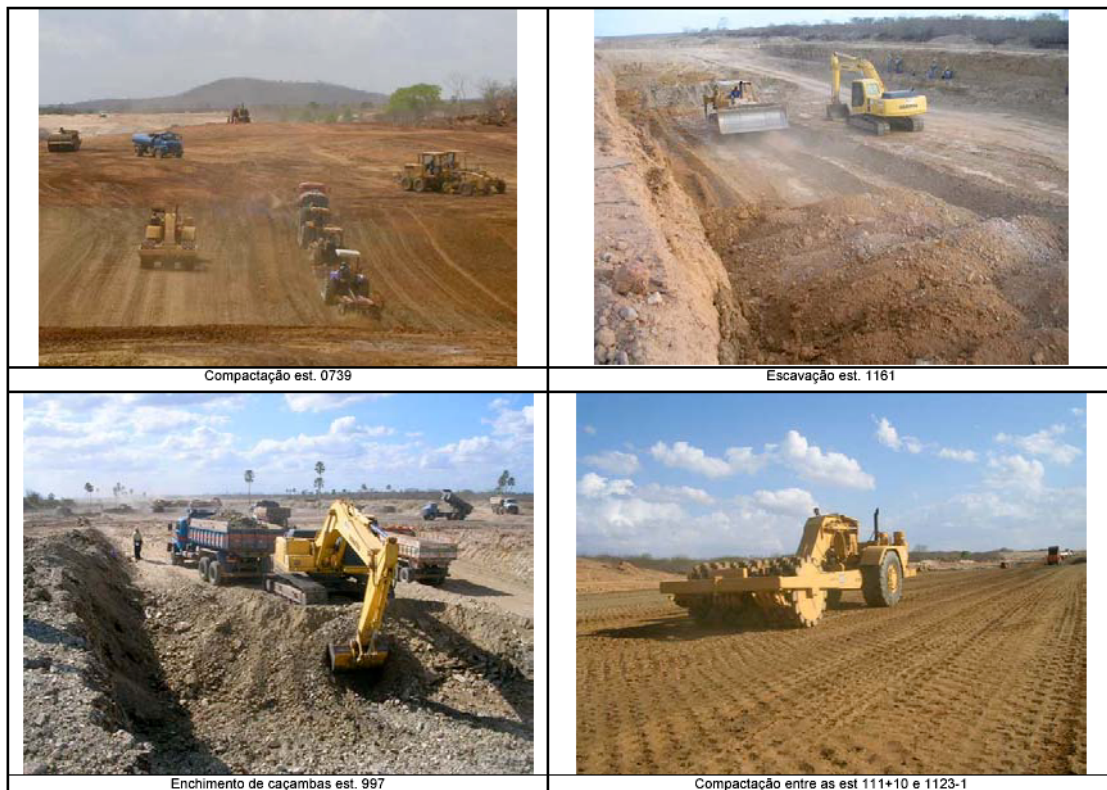
Figura 25: Canal da Integração. Trecho II. Fonte: SRH, dez 2005
