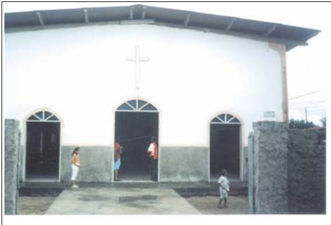
FIGURA 3 – Capela Santa Clara, na Comunidade de Vale Dourado, Zona Norte, Natal (ago. 2006)
