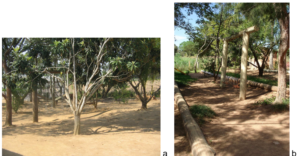
Figura 43: Aspecto do pátio, referente ao problema de erosão (a) com ocorrência de erosão, antes das modificações (b) com os patamares de Eucalipto, contendo a erosão, quatro meses após as modificações
