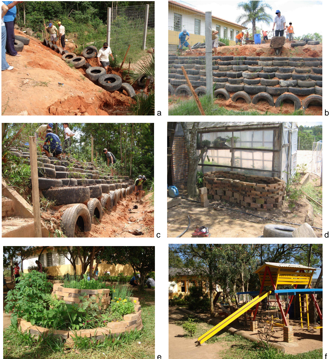
Figura 09: Aspectos das benfeitorias realizadas no pátio da Escola 2 (a), (b) e (c) fases da construção do talude de pneus usados, executado pelos pais, no dia do mutirão (d) composteira construída no dia do mutirão (e) espiral de ervas, já desenvolvida, um mês após a sua construção (f) aspecto do pátio, com destaque para um de seus equipamentos, 10 meses após a realização das modificações
