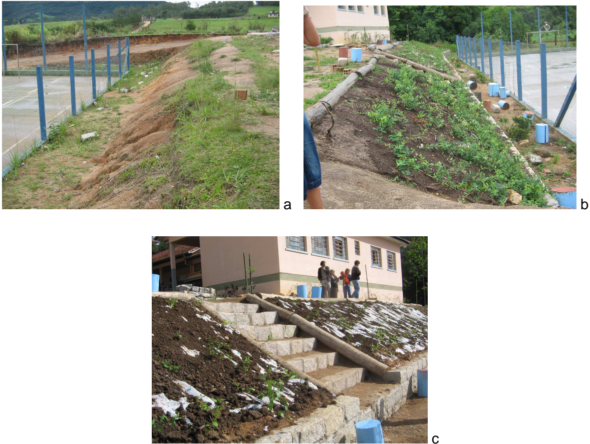
Figura 15: Controle de erosão no talude de acesso à quadra (a) aspectos do talude antes das modificações (b) talude 10 dias após as modificações no pátio (c) detalhe da escada de acesso a quadra, construída no dia do mutirão
