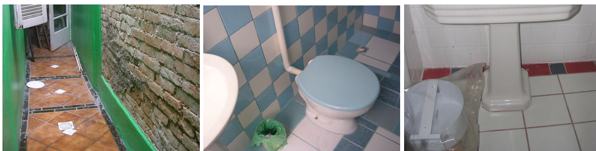
Figura 67: Peças cerâmicas de revestimentos (componentes): produtos de demolição (Projetista 05)
