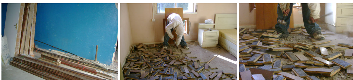
Figura 47: Revestimento com encaixe (E) e parquet (D); demolição D (Empresa 07)
