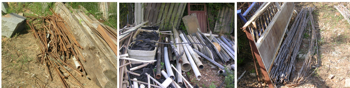
Figura 64: Revenda de tubulações metálicas, plásticas e ferragens (Empresa demolidora 07)
