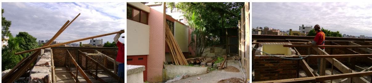
Figura 45: Estrutura do telhado: demolição D (Empresa 07)
