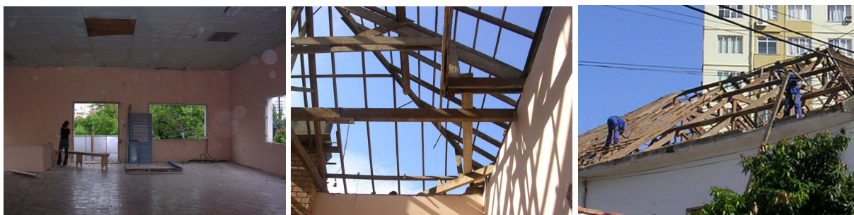
Figura 48: Forro e piso não removido (E) e estrutura de madeira; demolição A (Empresa 05)
