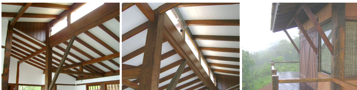
Figura 80: Peças estruturais (estrutura da cobertura e sacada) em madeira de demolição (Projetista 04)
