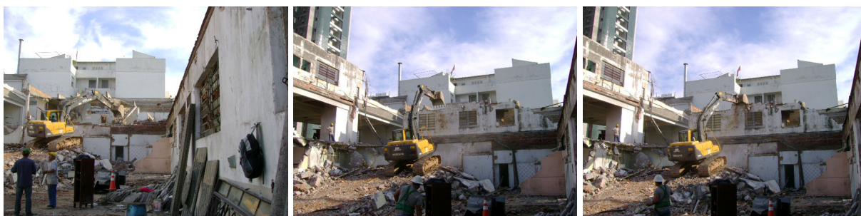
Figura 71: Estrutura com concreto, cerâmica e argamassa: materiais amorfos (Demolição E)
