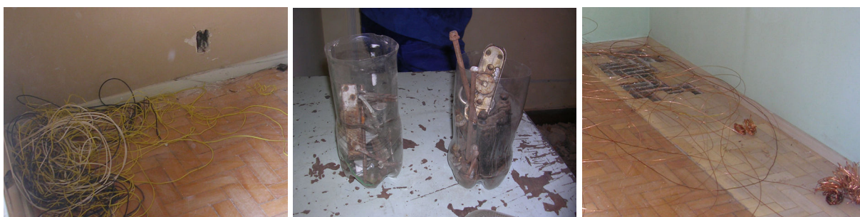
Figura 66: Fios descascados: reciclagem dos metais (material amorfo) (Empresa demolidora 05)
