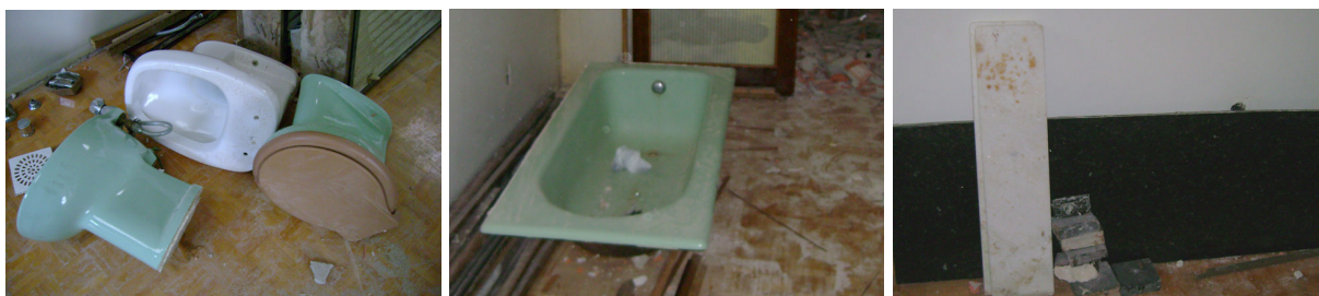
Figura 62: Cubas, banheira e tampo de mármore (componentes) retirados (Demolição D)
