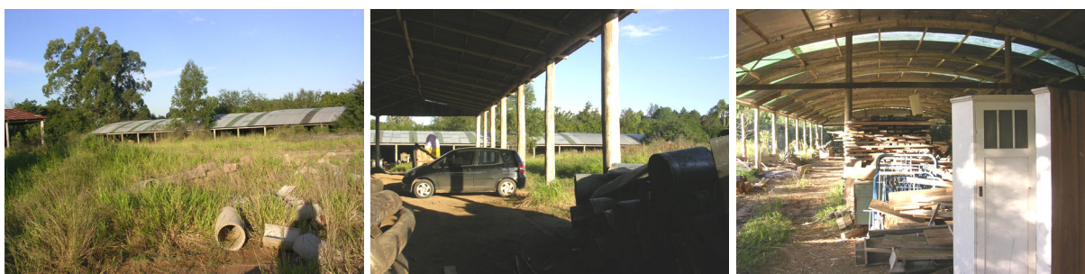
Figura 37: Galpões para armazenagem de materiais de demolição (Cliente final)
