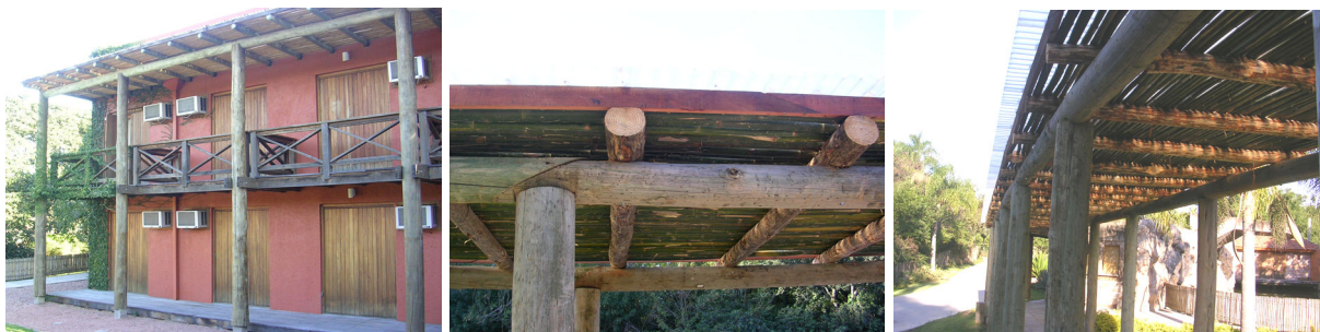
Figura 81: Peças estruturais (escada e estrutura da cobertura), em madeira de demolição (Projetista 08)
