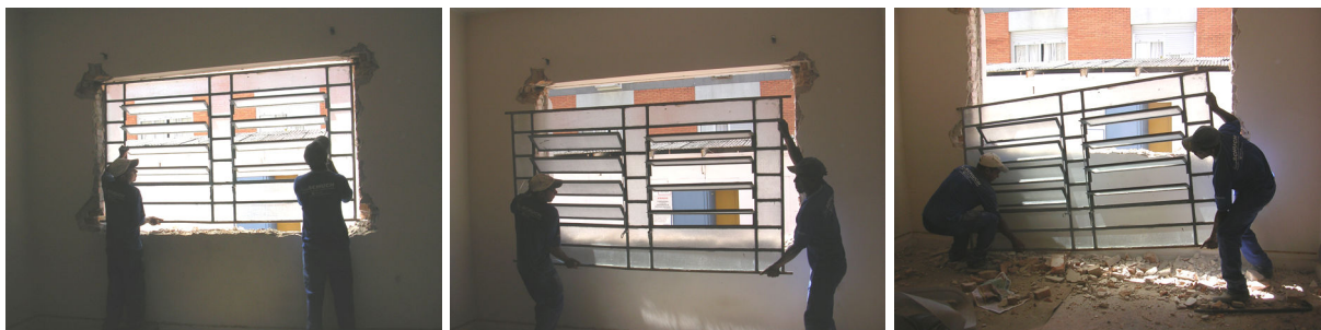
Figura 59: Massa e dimensão das esquadrias: maior complexidade para remoção (Demolição A)
