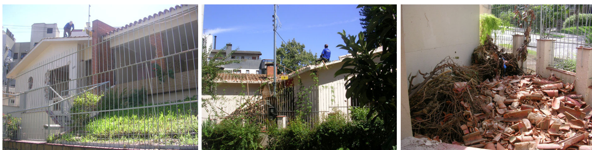
Figura 50: Telha cerâmica (material amorfo): demolição C (Empresa 05)
