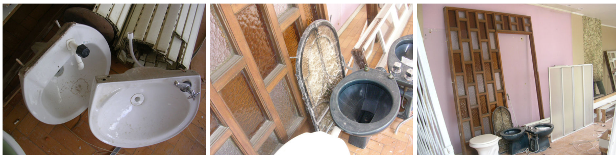
Figura 61: Cubas e vasos sanitários (componentes) retirados (Demolição C)
