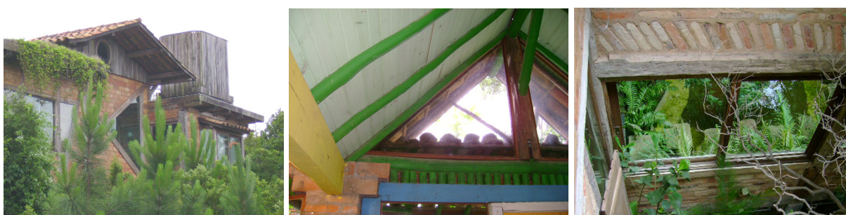
Figura 74: Esquadrias executadas em obra conforme dimensões do vidro (Projetista 04)
