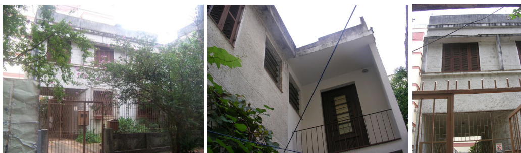
Figura 26: Edificação B: demolição B (Empresa 05)
