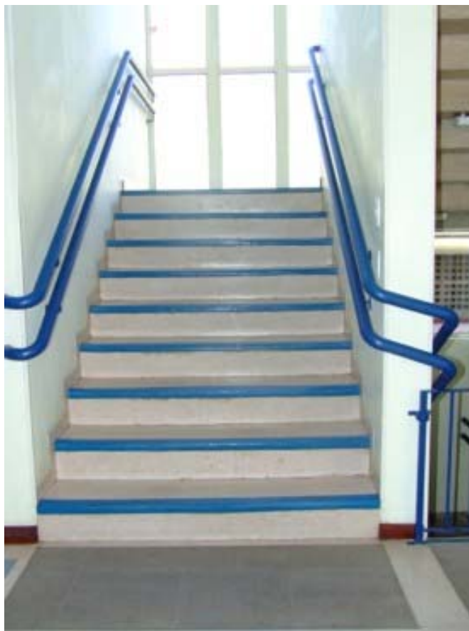
Figura 17: escada – cantoneira nos degraus e iluminação natural no patamar
