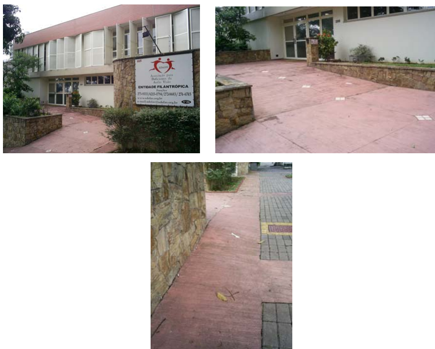
Figura 12: Acesso principal: rampas e calçada
