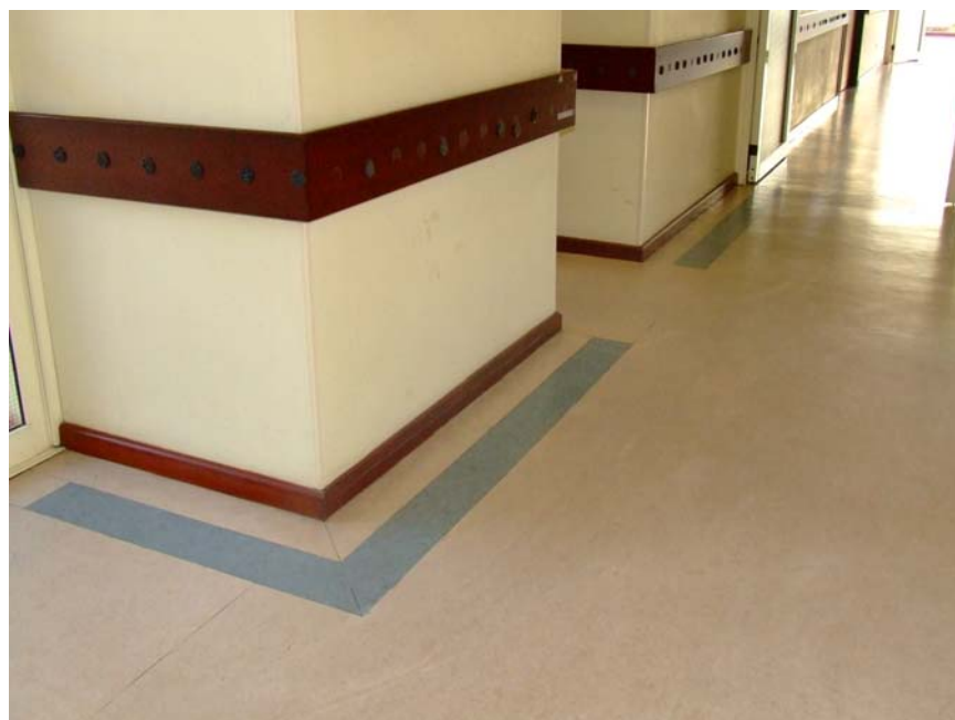
Figura 15: faixa próxima às paredes de cor contrastante com a cor do piso
