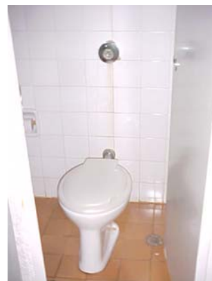
Bacia sanitária com válvula de descarga
