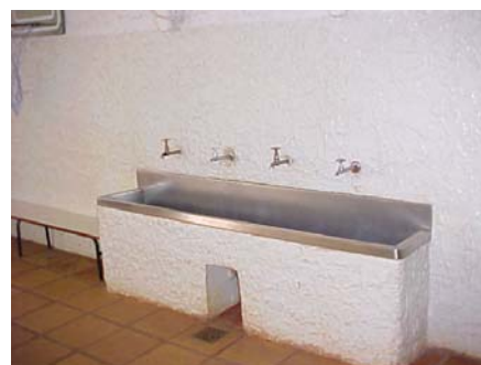
Torneira de lavatório tipo calha
