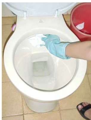
(a) secagem do poço da bacia
