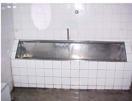
Registro de mictório tipo calha
