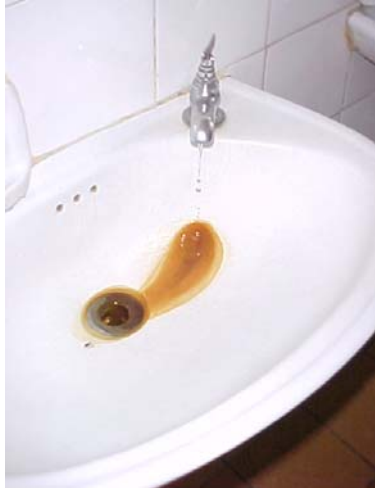
Torneira de lavatório com vazamento
