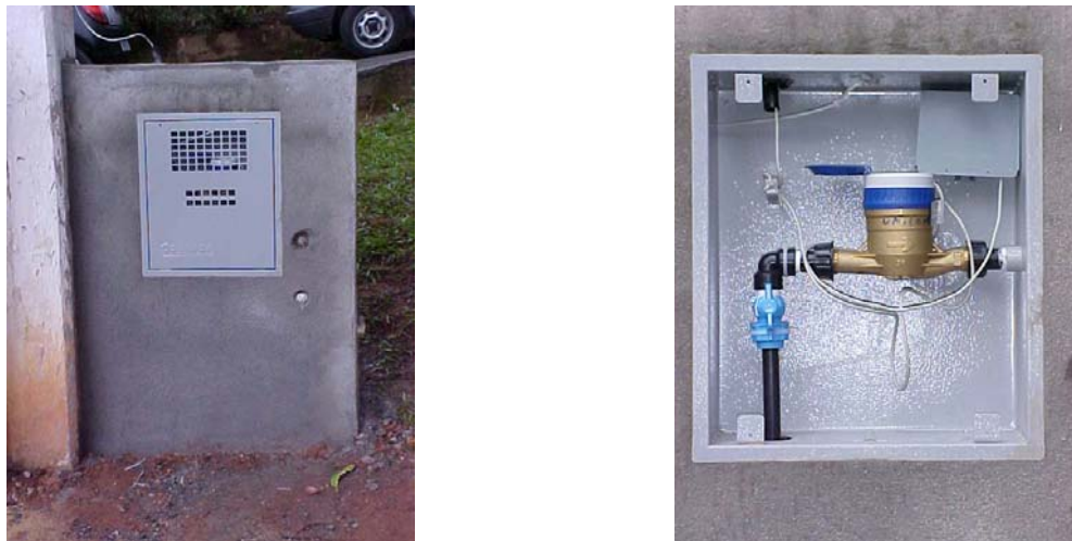
Figura 3.3: : Instalação da caixa de proteção do hidrômetro e da interface remota.
