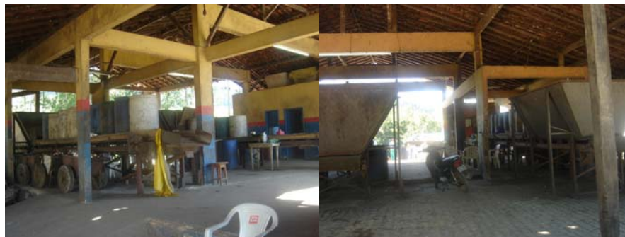
Foto 35: Usina paralizada devido à necessidade de modernização
