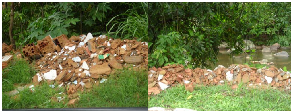
Foto 152: Disposição inadequada de RCC em Cachoeiras de Macacu
