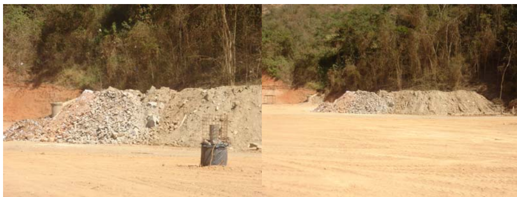
Foto 73: Resíduos de construção civil dispostos no aterro municipal
