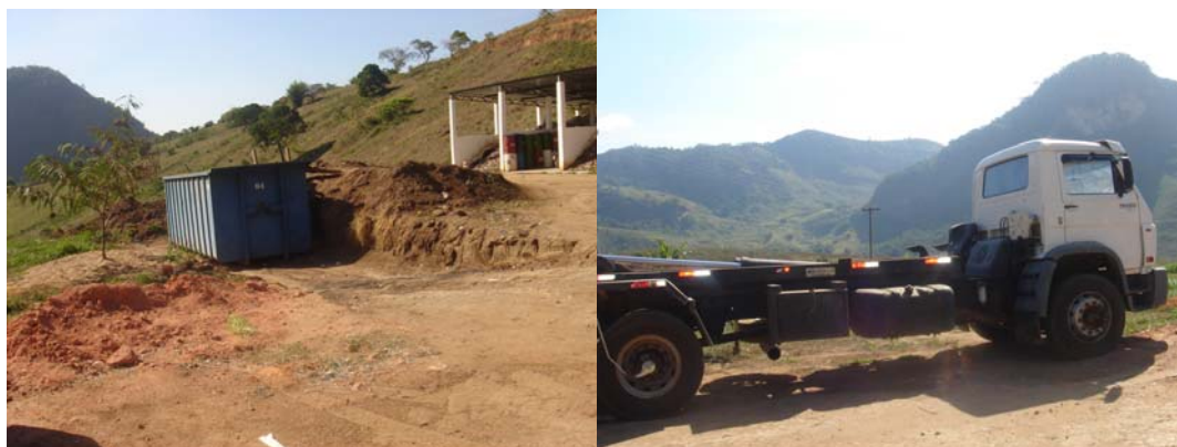
Foto 120: Container da Empresa MTR e caminhão para transporte até o aterro
