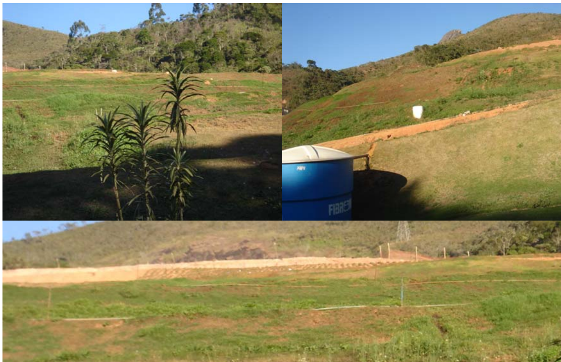
Foto 64: Aterro de Nova Friburgo
