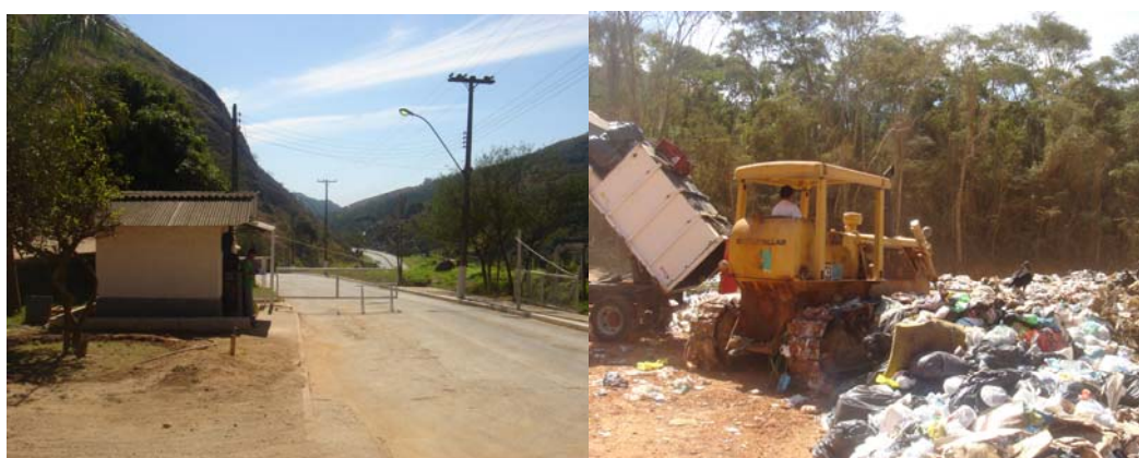
Foto 74: Controle do acesso no aterro / trator operando na frente de trabalho
