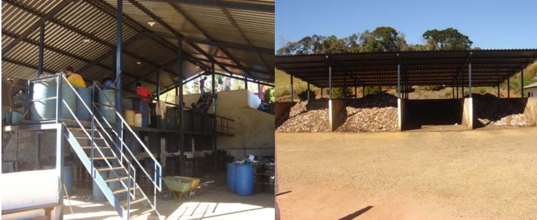
Foto 54: Usina de Reciclagem e Compostagem de Duas Barras
