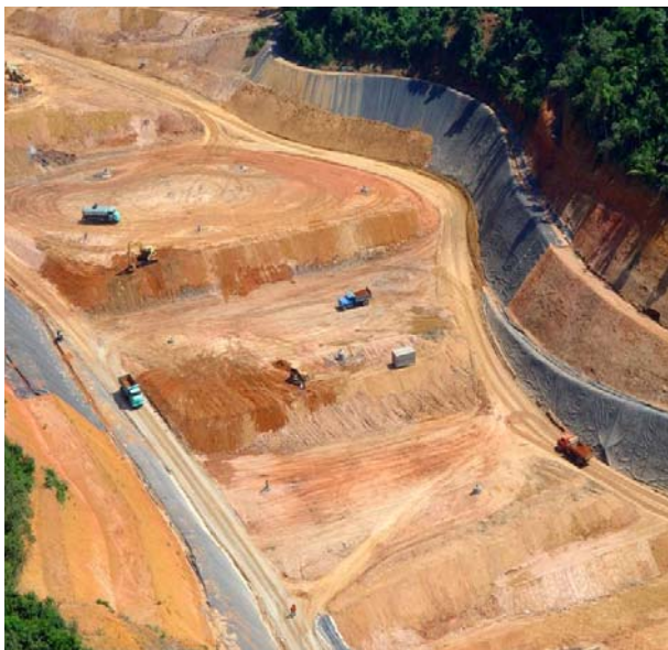
Foto 2 : Aterro Sanitário de Nova Iguaçu – RJ Fonte: www.novagerar.com.br
