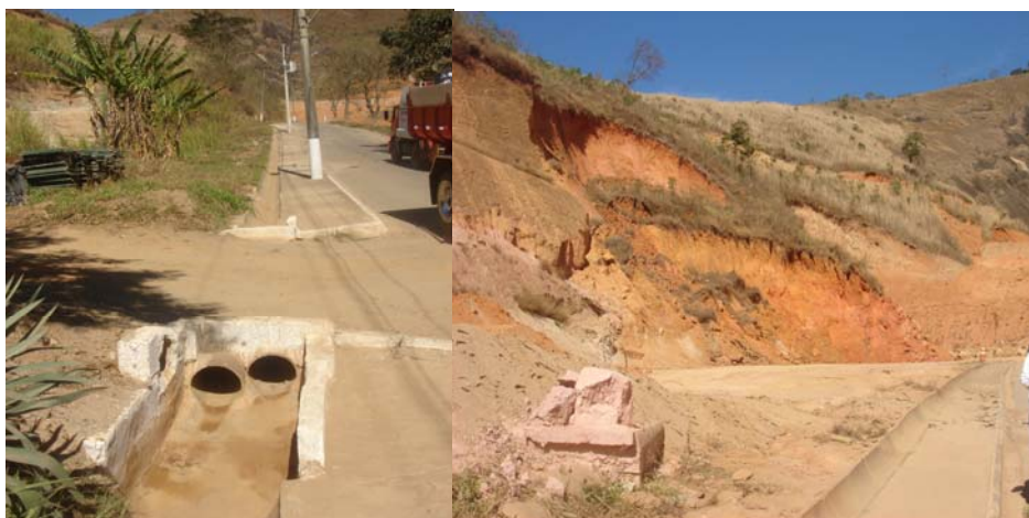
Foto 75: Drenagem da água pluvial /escorregamento na jazida
