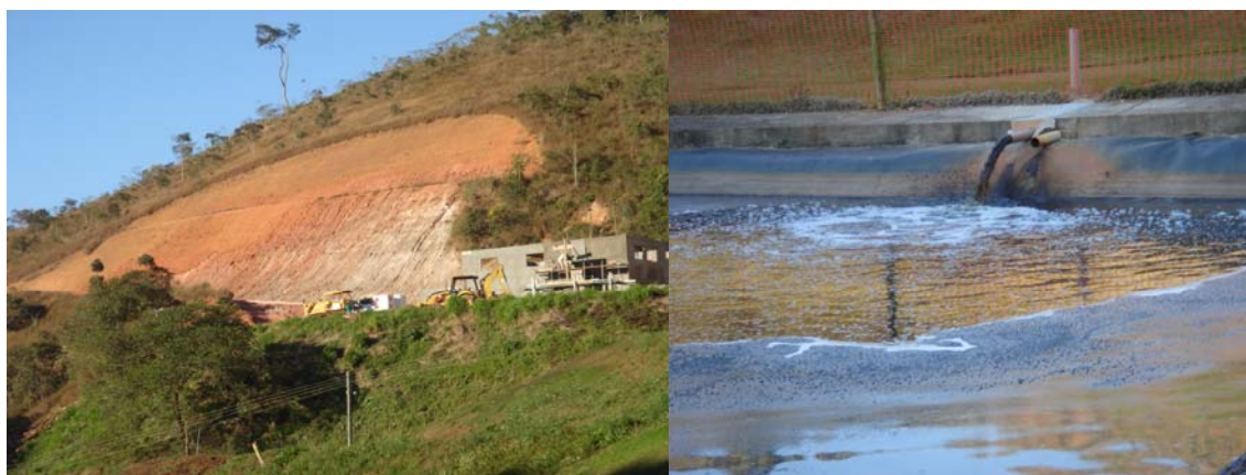
Foto 66: Construção de local para incineração de RSS / sistema de tratamento de chorume
