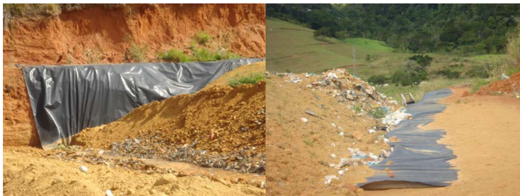
Foto 135: Manta de impermeabilização da base do aterro
