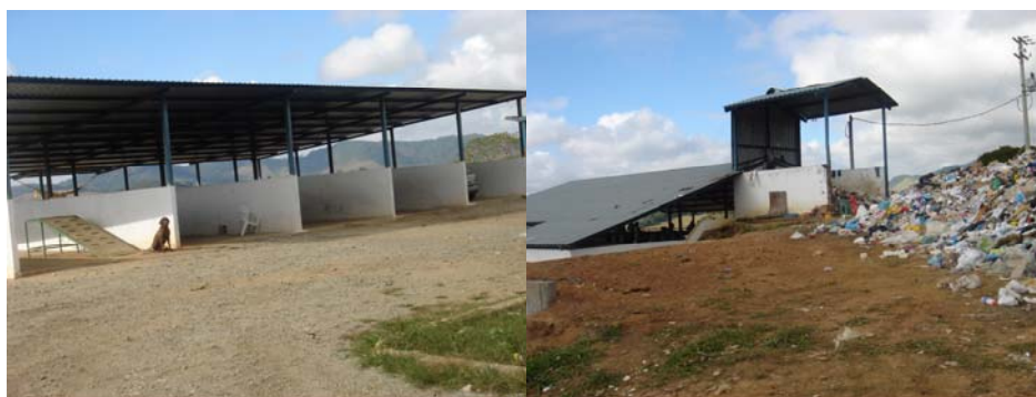
Foto 51: Baias de aeração do composto/ Recepção de resíduos na usina de Cordeiro
