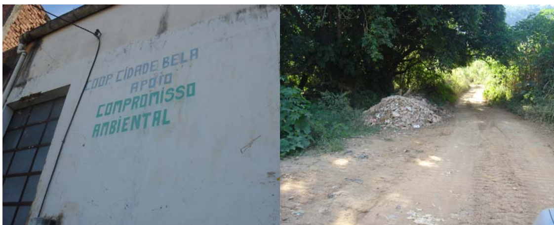
Foto 28: Galpão de reciclagem e RCC depositado em estrada vicinal aguardando compactação
