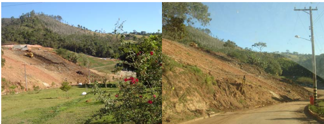
Foto 147: Deslizamento no maciço de lixo ocorrido no aterro de Nova Friburgo
