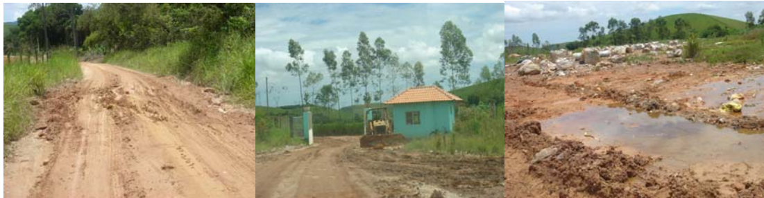
Foto 15: Acesso ao vazadouro / guarita no local / acesso à frente de trabalho
