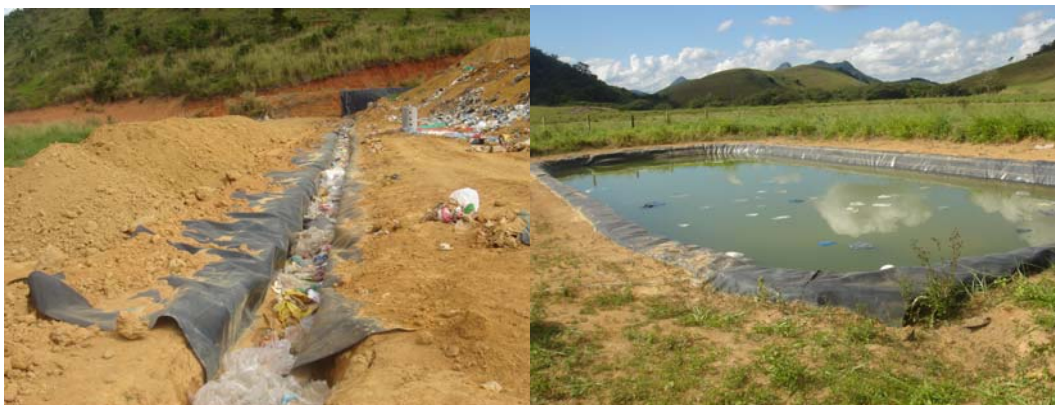
Foto 136: Canaleta para drenagem de chorume e lagoa de estabilização do chorume
