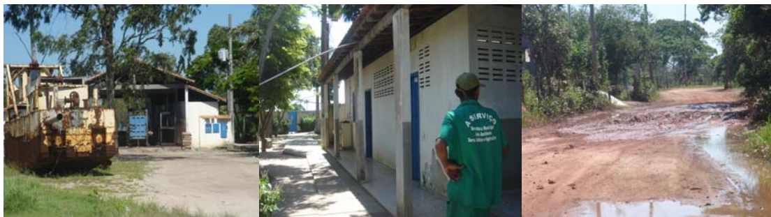
Foto 84: Usina paralizada devido à exigências do Ministério Público/ estrada de acesso
