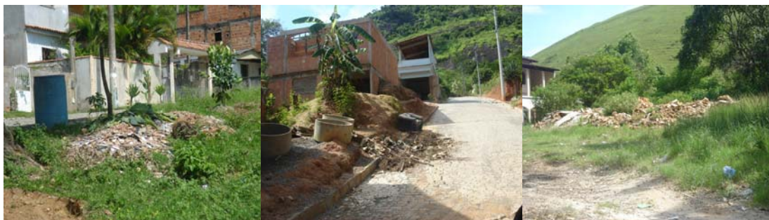
Foto 46: Resíduos de construção civil dispostos inadequadamente
