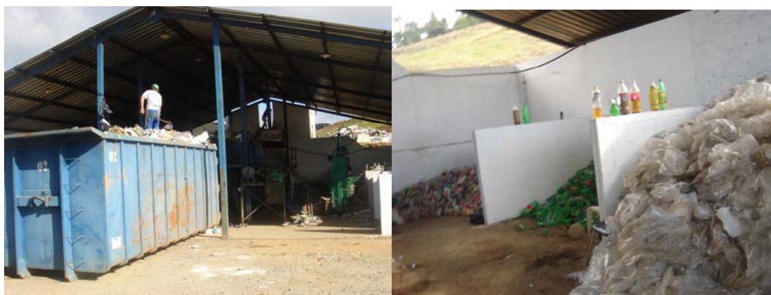
Foto 50: Aspectos da Usina de compostagem e reciclagem de Cordeiro
