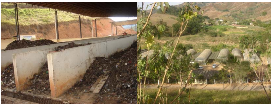
Foto 98: Baias de compostagem do resíduos orgânicos/ Horto Municipal
