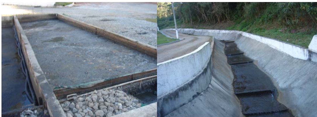
Foto 67: Leito de secagem / canal de drenagem das nascentes existentes no terreno
