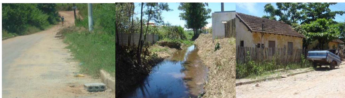
Foto 23: Falta de limpeza de sarjetas e bueiros /margens de um rio / veículos abandonados
