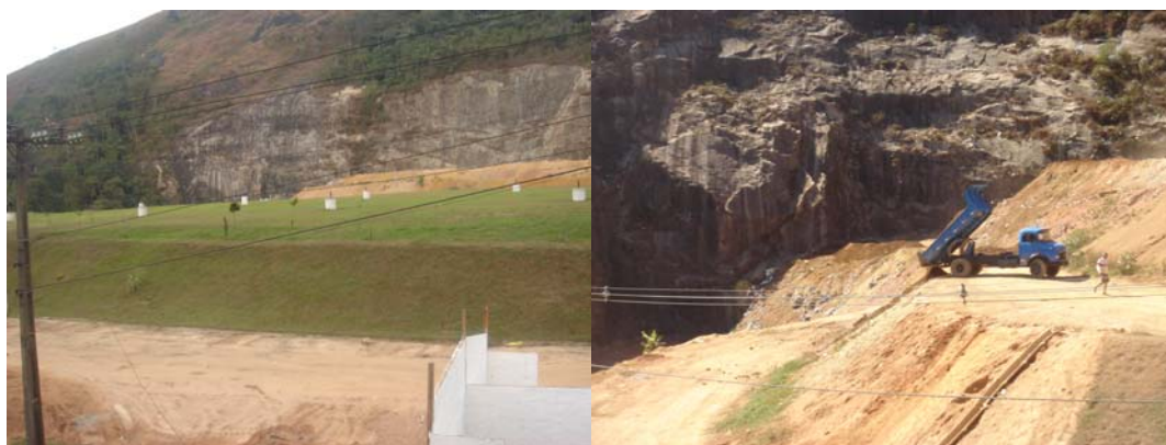
Foto 124: Área de disposição final encerrada / área em operação
