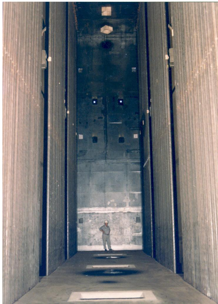
Figura 3.8 - Vista interna do forno de radiação, apresentando nas laterais os tubos de troca térmica ASTM 268 Gr. 446 [PETROBRAS, 1994].
