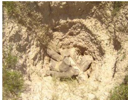
Fig. 5f - Poço abandonado inadequadamente.
