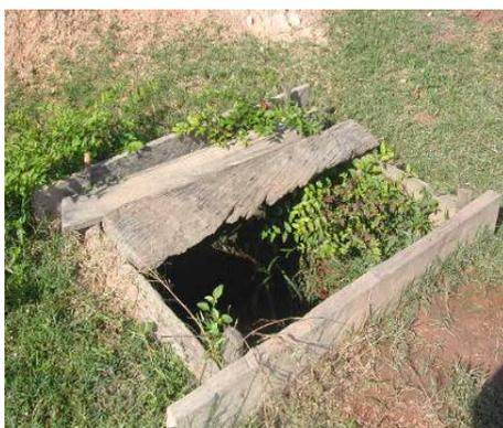
Fig. 3f – Poço isento de qualquer fator de proteção
