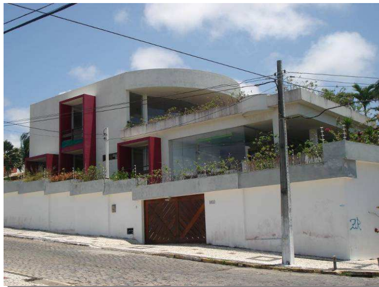
Figura 42 – Prédio residencial (bairro de Ponta Negra). Fonte: http://www.skyscrapercity.com/showthread.php?t=524061
