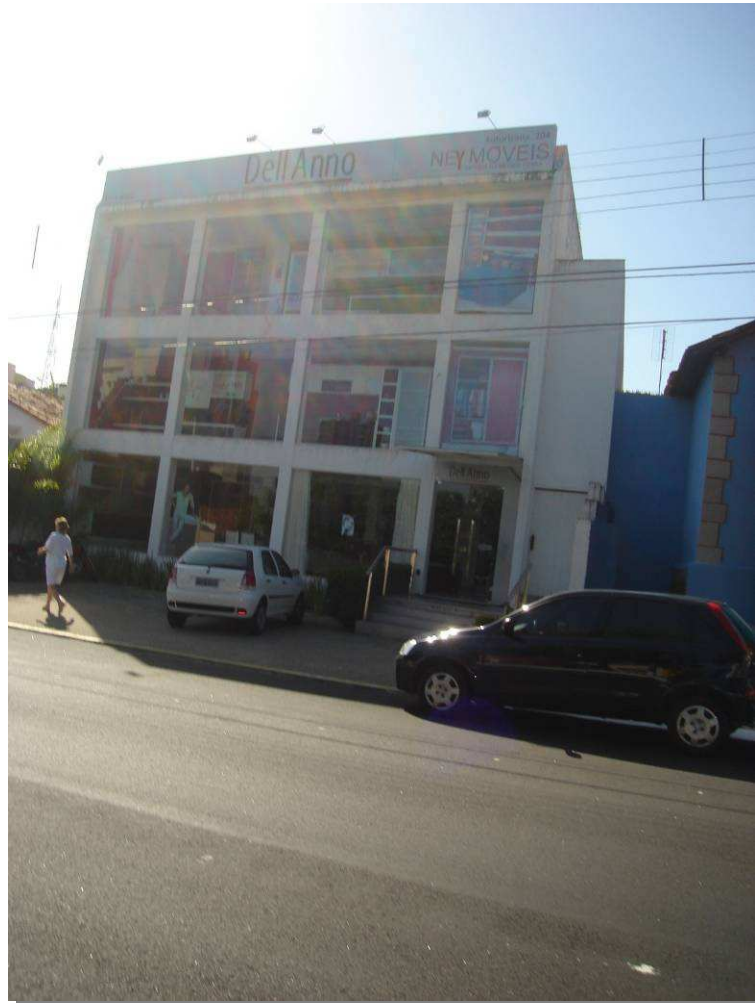
Figura 34 – Loja Ney Móveis (fachada principal) Foto: Suerda Campos da Costa, 2007
