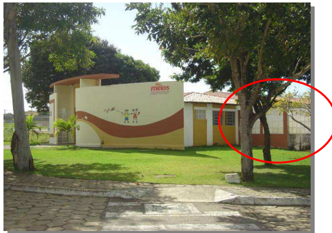
Figura 58 - Uso de cobogós – fachada da Creche Estadual do Centro Administrativo (Profissional 03) Foto: Suerda Campos da Costa, 2007
