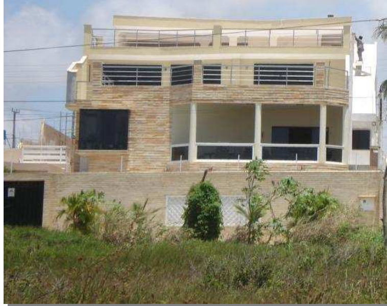
Figura 41 – Prédio residencial (bairro de Ponta Negra). Fonte: http://www.skyscrapercity.com/showthread.php?t=524061
