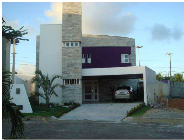
Figura 55 - Utilização de platibanda – Fachada principal de uma residência unifamiliar Foto: Profissional 04
