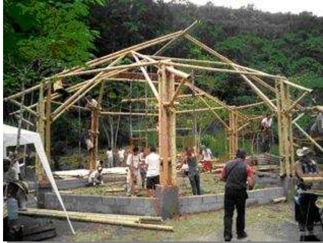
Figura 17 - Construção em bambu Fonte: ARCHIDOMUS, 2007
