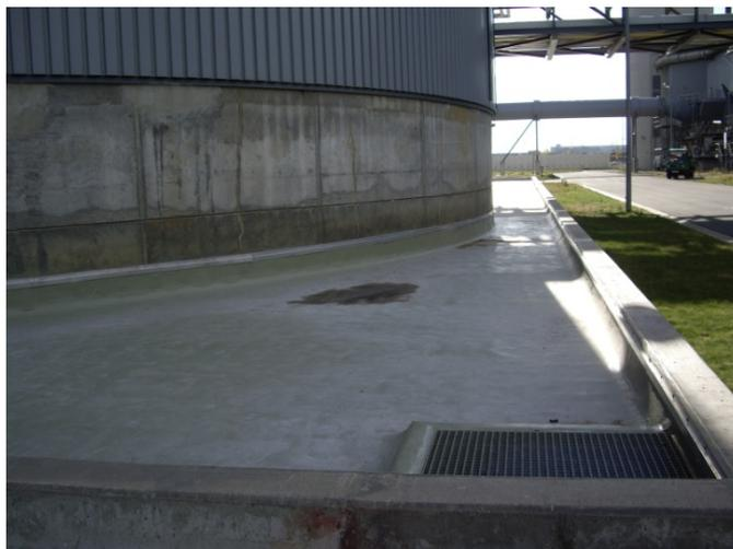
**Figura 11 – Estrutura de proteção para vazamentos ao redor do tanque e poço para coleta de vazamentos.**
