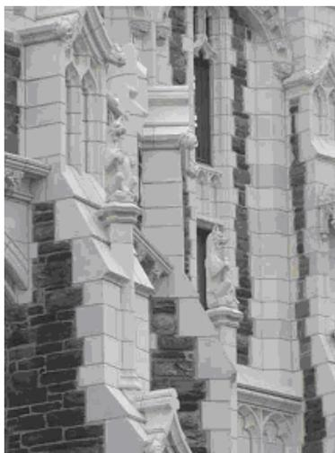
**Figura 55. Peças pré-fabricadas de GRFC confeccionadas com a incorporação do MCAR**
