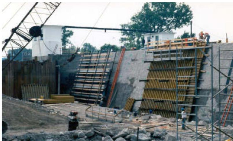
**Figura 56. Aplicação do concreto com MCA para revestir o canal Eire, Nova York.**
