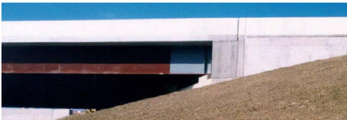
**Figura 52. Guarda-corpos fabricados com concreto de cimento Portland branco e MCAR de modo a aumentar a reflectância da luz durante neblinas e o período noturno.**
