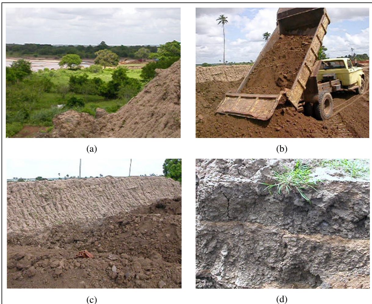
Figura 2.5 – Etapas de extração da argila: (a) jazida próxima ao local de armazenamento; (b) transporte feito por caminhão basculante; (c) e (d) argila armazenada.
