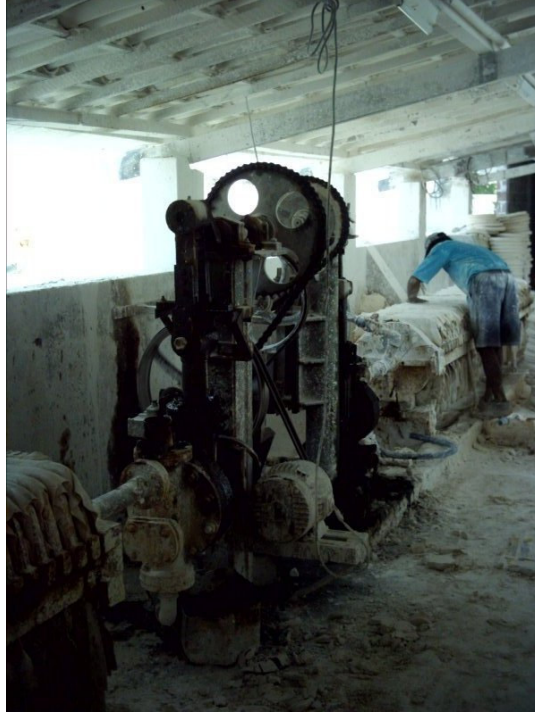
Figura 13 – Prensa hidráulica para retirada do excesso de água do caulim.
