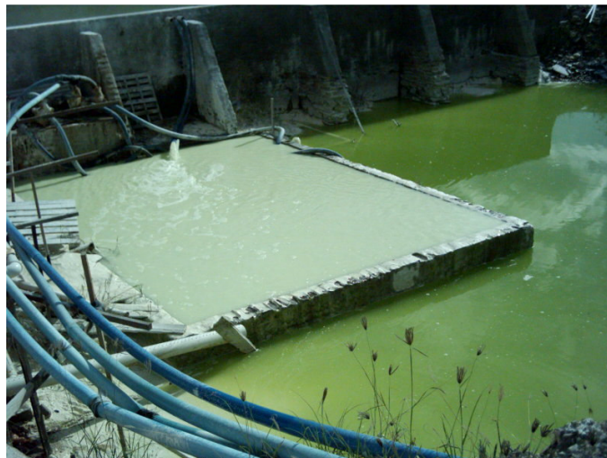
Figura 10 – Tanque de decantação I
