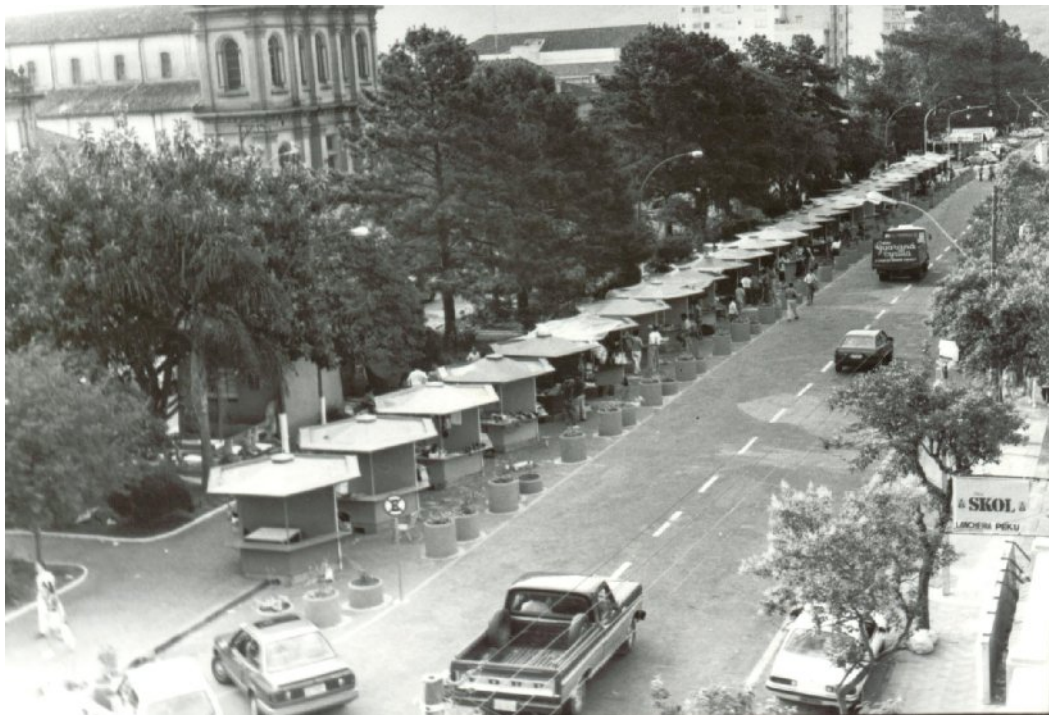
Figura 17: Foto da Avenida Rio Branco, e seu canteiro central com a construção das edificações dos vendedores informais. Fonte: Arquivo Histórico Municipal.
