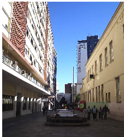
Figura 32: Atual estado de manutenção da Rua Alberto Pasqualini, (Rua 24 Horas) Fonte: original do autor
