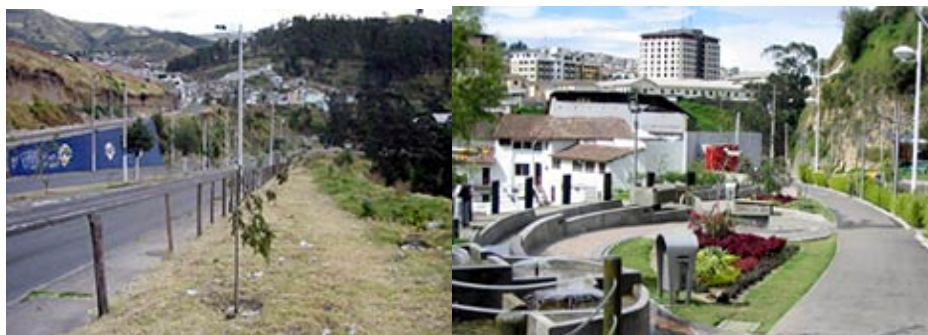
FIG. 124,125 – ANTES E DEPOIS DAS OBRAS DO PARQUE LINEAR MACHÁNGARA FONTE: VIDAPARAQUITO, 2006
