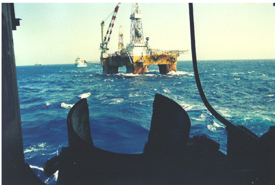
Figura 87 Alinhamento entre a unidade, que está com o topo do SCR e flex-joint , e o receptáculo da plataforma.
