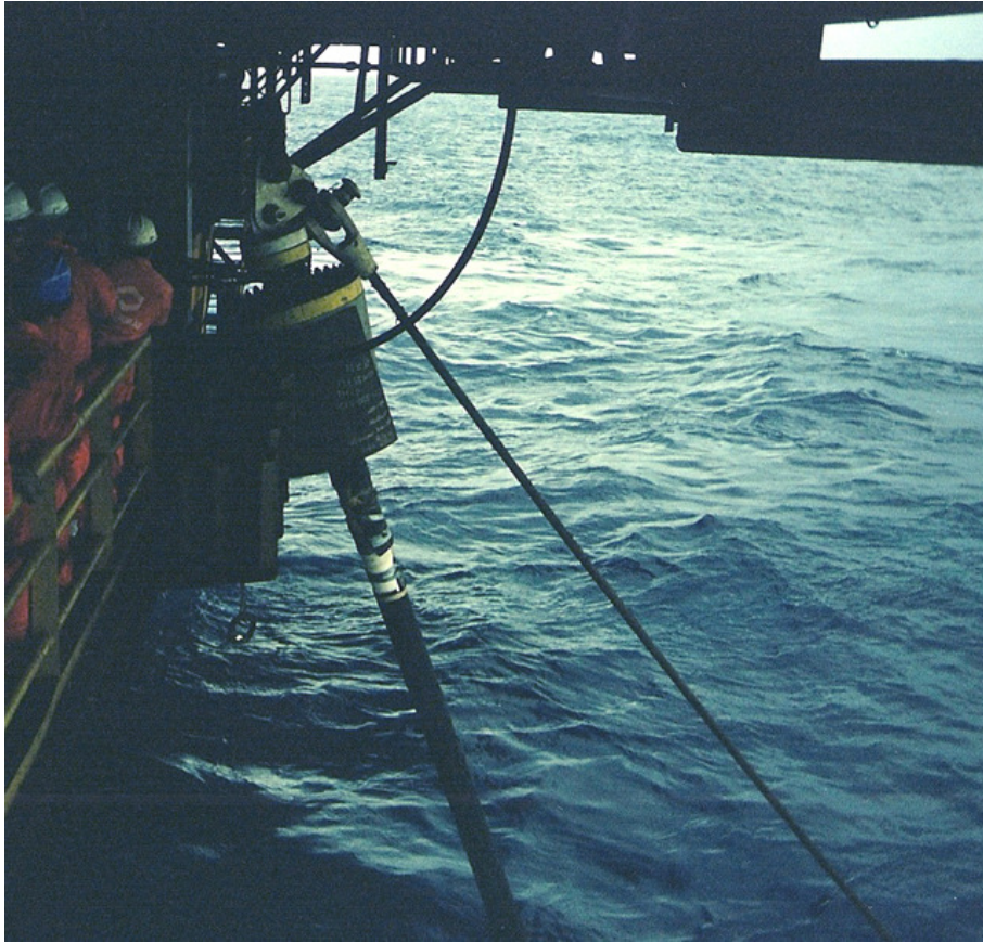
Figura 92 Flex-joint sendo alojada no receptáculo, finalizando operação de pull-in.
