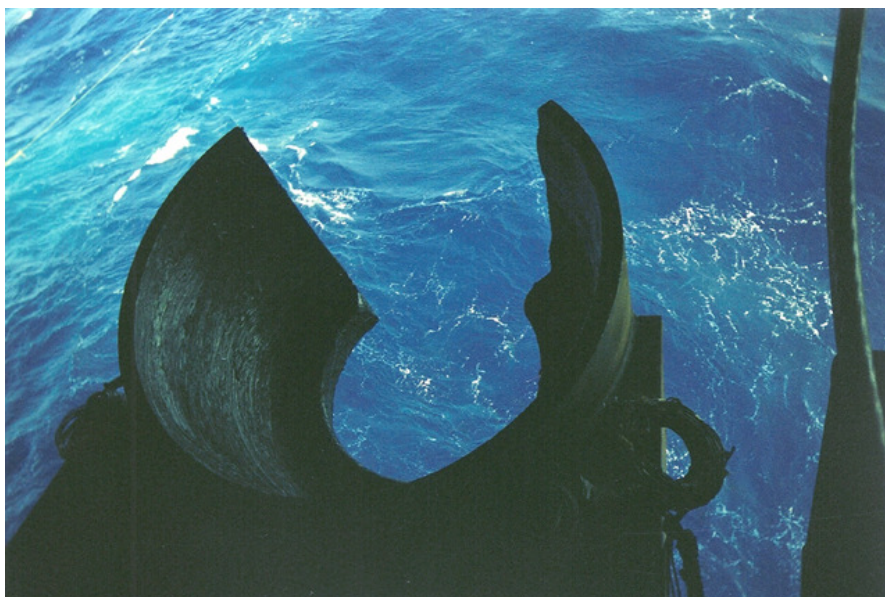
Figura 88 Vista de cima do receptáculo do SCR.
