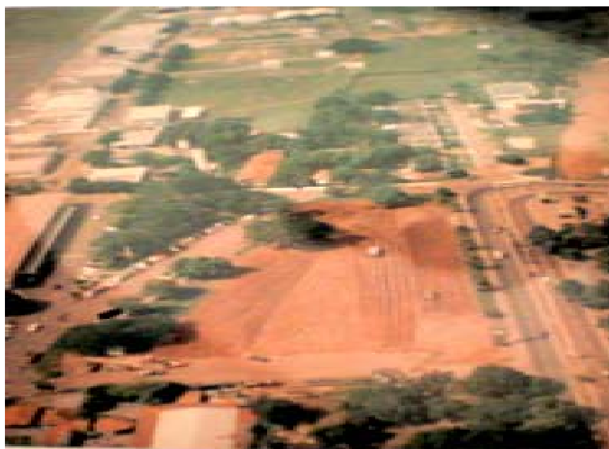
FIGURA 3 – Vista aérea das obras de reforma, com ampliação da área para estacionamento de veículos.
