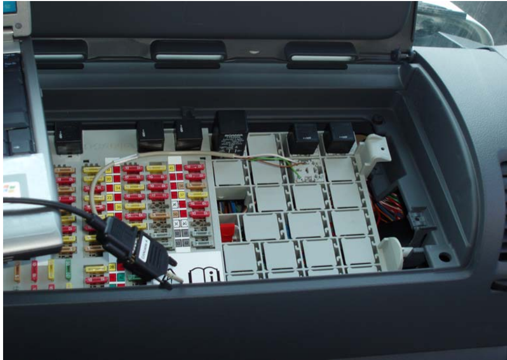
Figura 44 - Conexão da ferramenta de análise (CANalyzer) na central elétrica.
