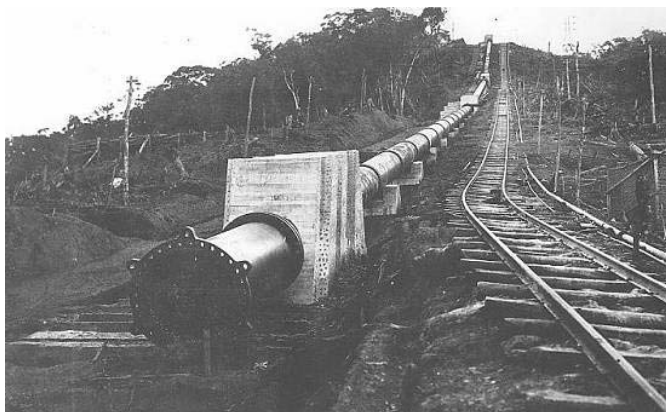
Foto 4 - Primeiras tubulações da Usina Henry Borden. Ao lado, a via férrea exclusiva para a construção. Esse sistema era e ainda é operado por troles rebocados por cabos, devido à alta declividade
