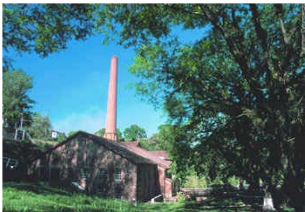
Foto 1 - Casa de máquinas da hidrelétrica e da casa de máquinas pela Cia. Mechanica Industrial Rio Clarence, construída em 1893, Rio Claro – SP Acervo: Fundação Patrimônio Histórico da Energia de São Paulo
