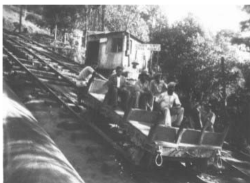
Foto 5- Trole usado nas linhas do Plano Inclinado, Usina de Henry Borden – Cubatão – São Paulo (década de 1930- Fonte Jornal Curtas de HB - 05, no.23)
