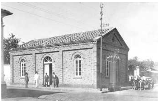
Foto 2 - Subestação na Cidade de Rio Claro, 1899. Acervo: Arquivo Municipal de Rio Claro – SP
