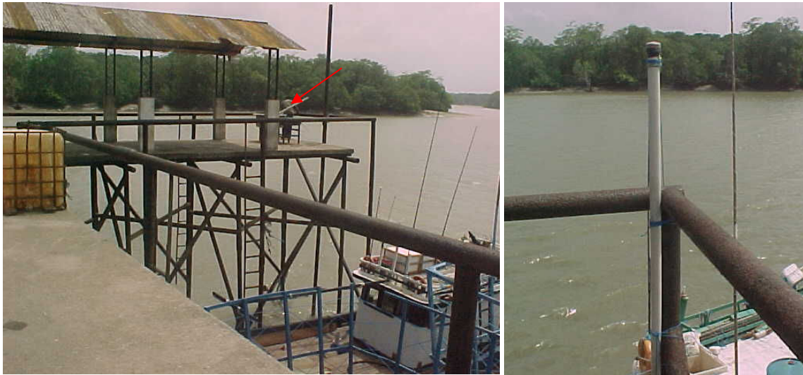
Figura 38: Marégrafo M1 (seta vermelha) instalado no trapiche da fábrica de gelo Pesqueira Maguary.
