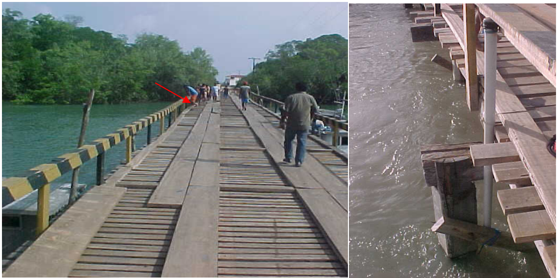
Figura 39: Marégrafo M2 (seta vermelha) instalado na Vila dos Pescadores sob a ponte do Furo Maguary.
