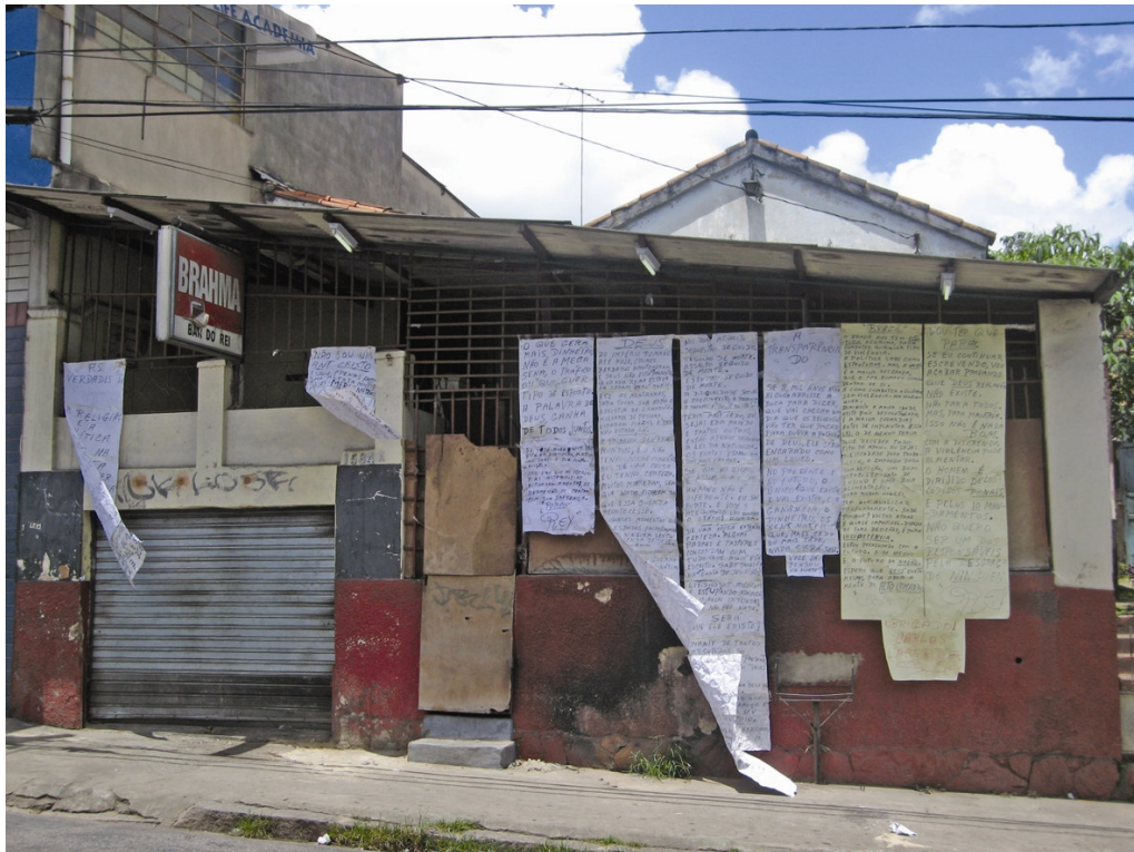
FIGURA 7: instalação de desconhecido em fachada da Rua Niquelina. Fonte: MAGALHÃES, Maria Beatriz de Almeida, 2007.
