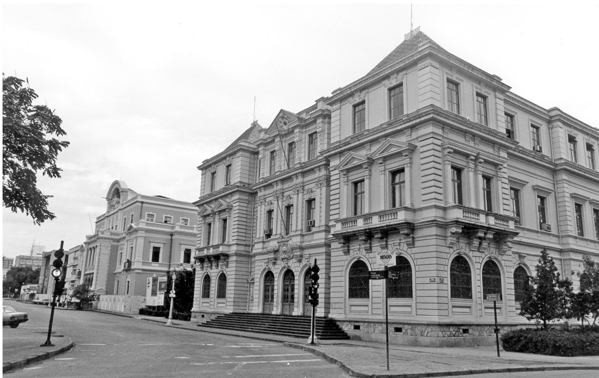
FIGURA 22: duas das três Secretarias de Estado construídas pela Comissão Construtora na Praça da Liberdade. Fonte: MAGALHÃES, Beatriz de Almeida; ANDRADE, Rodrigo Ferreira, 1989.
