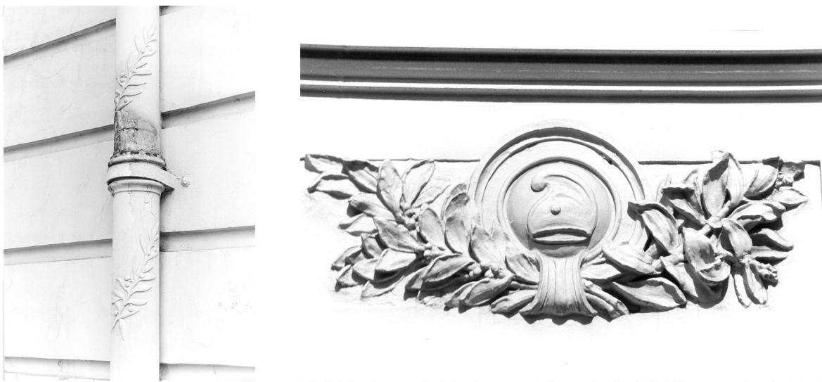
FIGURA 26: tubulação pluvial em uma das Secretarias e ornato com barrete frígio no Palácio da Justiça. Fonte: MAGALHÃES, Beatriz de Almeida; ANDRADE, Rodrigo Ferreira, 1989.
