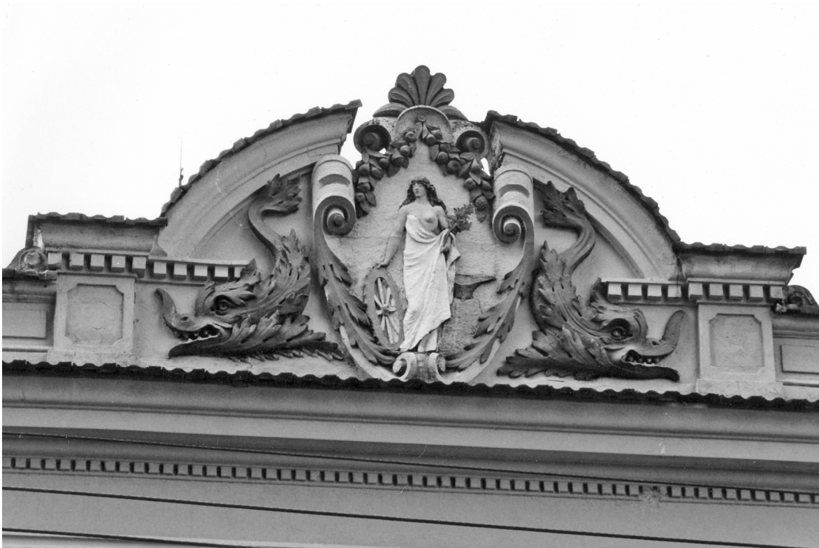
FIGURA 28: frontão da casa de Carlo Antonini, na esquina da Rua da Bahia com a Rua Bernardo Guimarães. Fonte: MAGALHÃES, Beatriz de Almeida; ANDRADE, Rodrigo Ferreira, 1989.
