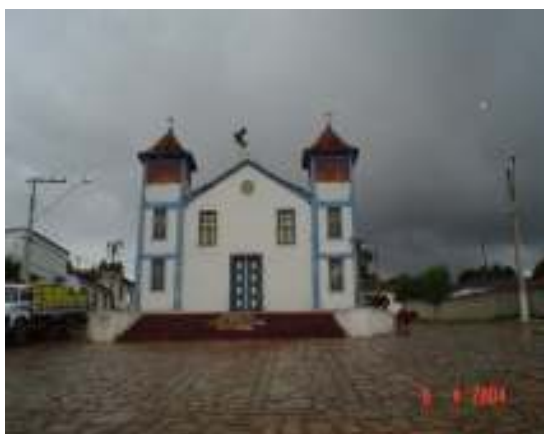
Foto 72: Matriz de Nossa Senhora das Dores Fonte: Claudia Freitas - Registro de Campo
