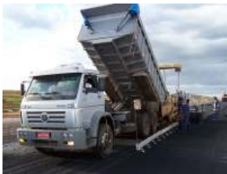
Foto 120: Obras no Aeroporto de Diamantina Fonte: site: www.fidens.com.br
