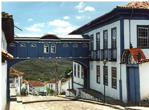
Foto 7: Casa da Glória – IGC-UFMG Fonte: Claudia Freitas – Registro de Campo
