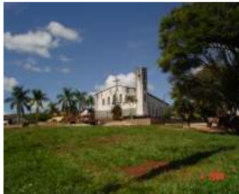
Foto 88: Igreja Nossa Senhora das Mercês Fonte: Claudia Freitas - Registro de Campo
