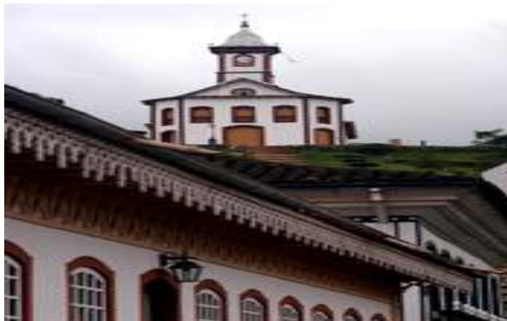
Foto 131: Restauro de imóveis privados Fonte: site: www.monumenta.gov.br
