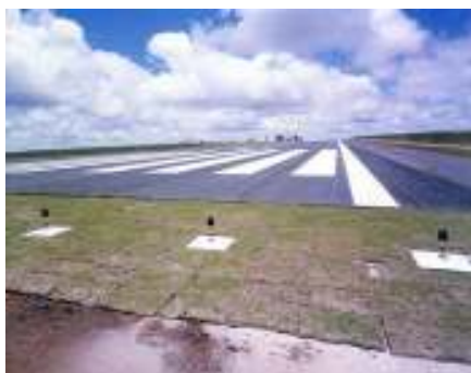
Foto 119: Obras no Aeroporto de Diamantina Fonte: site: www.fidens.com.br
