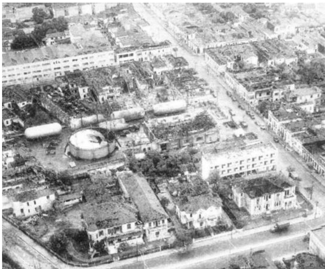
Panorâmica do Reservatório de Gás após explosão, em janeiro de 1967.
