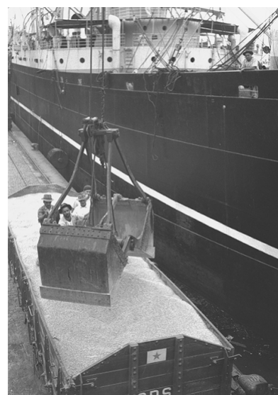
Descarregamento de soja a granel por meio de guindaste com equipamento específico aclopado. O produto foi direto dos vagões do trem para os porões do navio. Década de 1950, Gelatina/prata, 6x9cm. Acervo FAMS.
