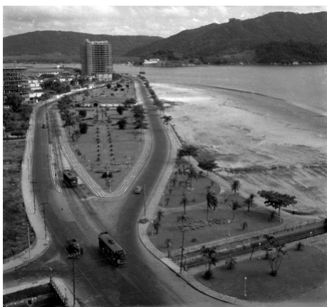
Edifício Enseada, o primeiro prédio na orla da Ponta da Praia, ainda em construção. Foi projetado pelo autodidata João Artacho Jurado, responsável por obras que se tornaram referência em Santos e São Paulo. Santos. Década de 1950. Gelatina/prata, 9x6cm. Acervo José Dias Herrera.
