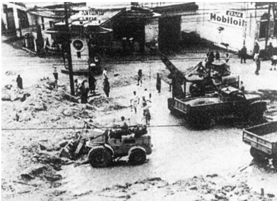
Retirada de lama, pedras e entulho das ruas atingidas pelo deslizamento no Morro do Marapé, no dia 1º de março de 1956.
