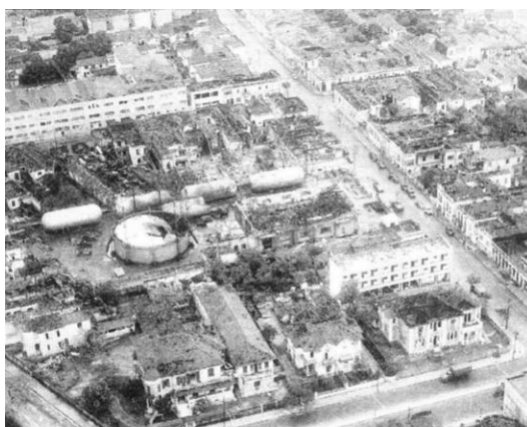
Panorâmica do Reservatório de Gás após explosão, em janeiro de 1967. Reprodução do jornal A Tribuna.
