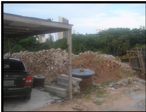
FIGURA 18 – Entulho produzido a partir das construções. FONTE – LIMA, 2007.
