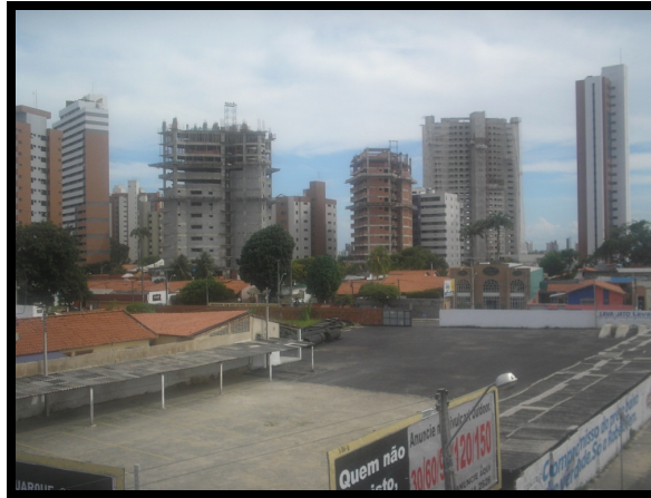
FIGURA 21 – Três novos edifícios vistos da Eng. Santana Júnior que passam a compor a paisagem.
