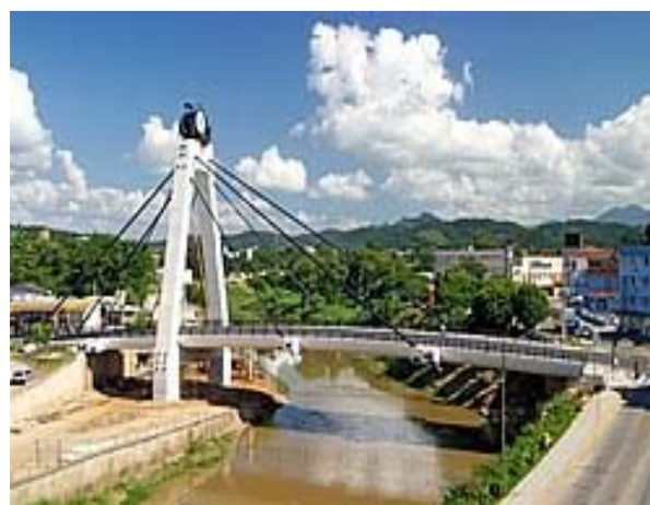
Figura 4.5 - Ponte Irineu Bornhausen, Brusque/SC Fonte: www.comunidadeconstrucao.com.br
