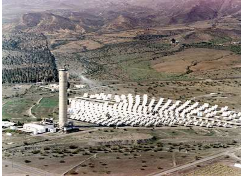
Figura 8. Campo Solar CESA 1 em Almería – Espanha.
