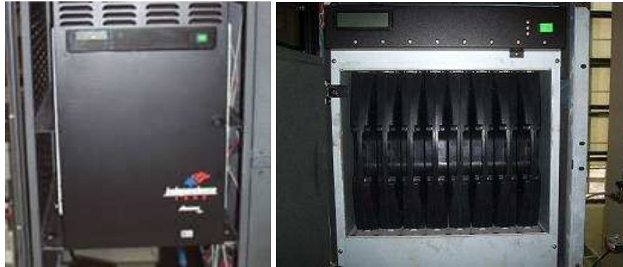
Fig. 2.3 Vista frontal; módulo Independence 1000™ fechado e aberto.
