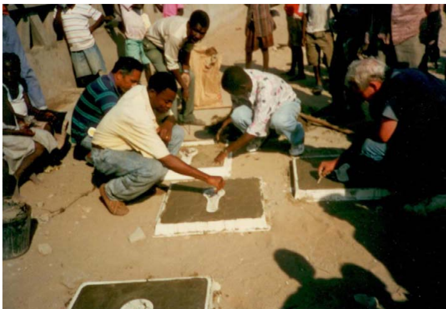
FOTO 07: CONSTRUÇÃO DE LAJES
