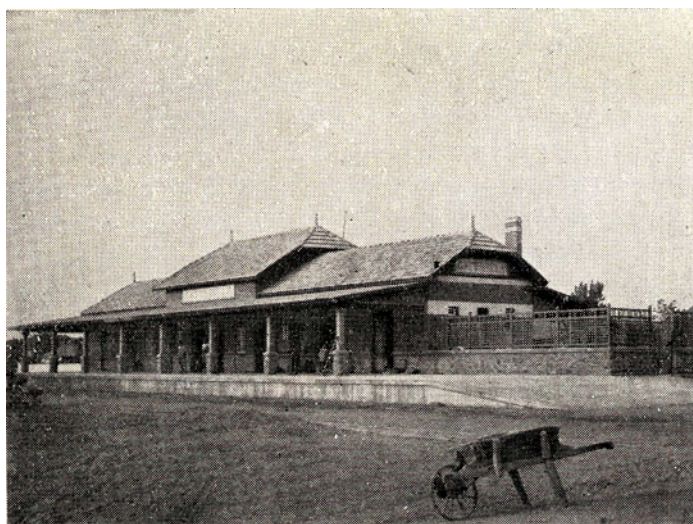
FIGURA 06: Estação da Catumbela 1922
