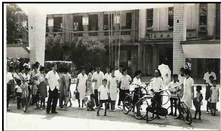
Fig.66- Escola Primária Municipal de Ping-Tung- Taiwan-1963
