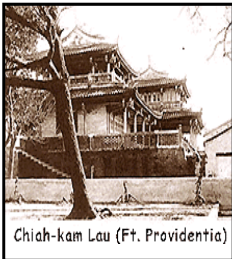
Fig. 70 – Fotos - Forte da Providência
