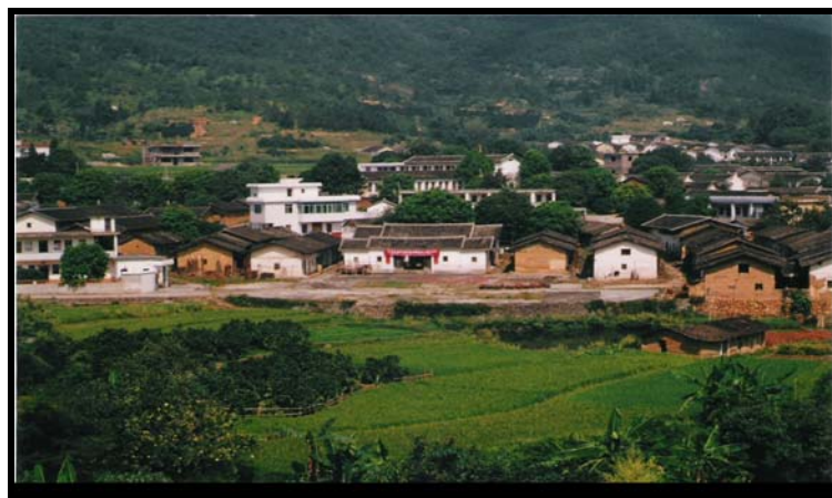
Fig.51- vista do alto da localização das residências e do templo da família Chiou
