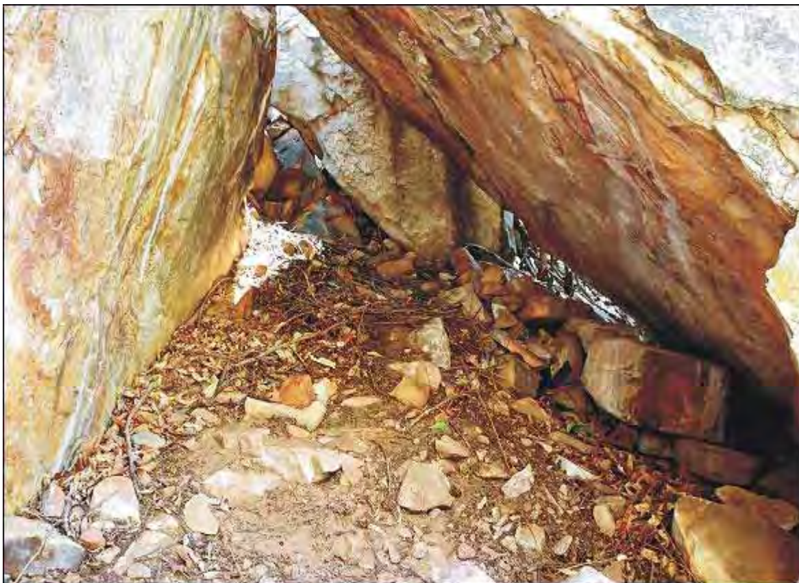
Figura 46 - Conservação por cobertura de bloco. Furna do Caçador – BRSG-21
