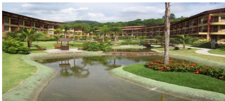
Fig. 10 - Área central do Resort.
