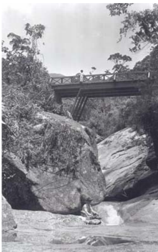
Figura 86 – Ponte sobre o Maromba (1937)
