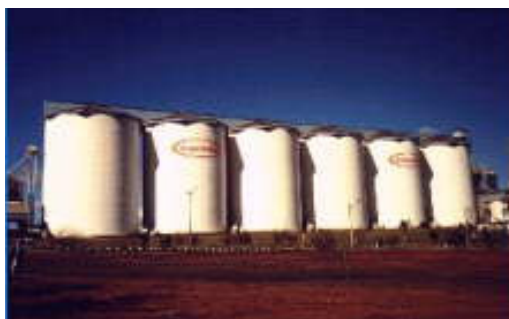
Figura 1: Silos de concreto
